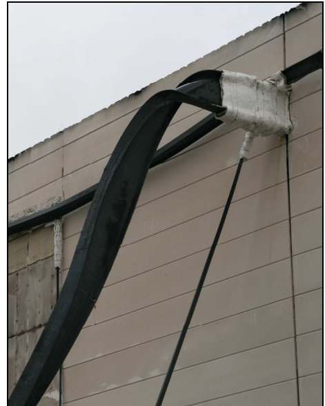
b) Viga de acero parcialmente protegida contra el fuego que atraviesa un muro cortafuegos fijado a los pilares de acero
