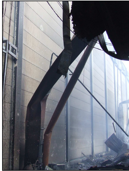
a) Muro cortafuegos con estabilidad propia insertado entre dos estructuras de acero independientes
