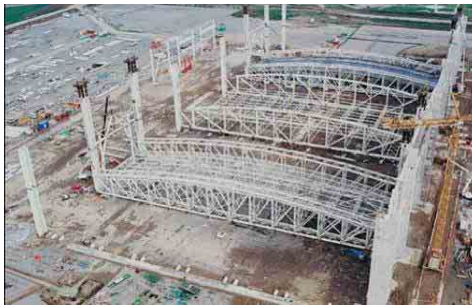
Rysunek 1.6 Kratownica typu N — rozpiętość 100 m
