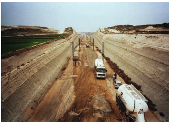
Estabilización de la plataforma en línea Zaragoza-Lérida
