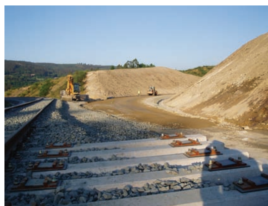
Tramo de conexión con el ramal estabilizado en Meirama
