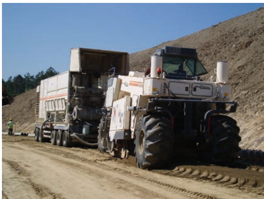
Equipo estabilizando la capa de forma
