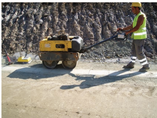
Compactación junto a arquetas
