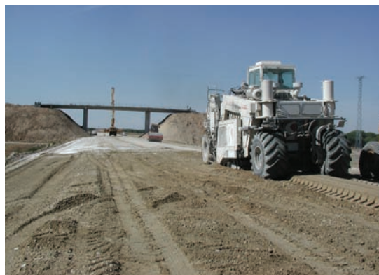
Estabilización de la capa de forma. Olmedo (Valladolid)
