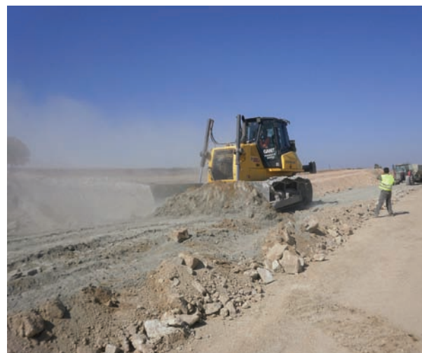
Estabilización de jabres y bolos que rellenan los huecos entre macizos de granito en Cáceres
