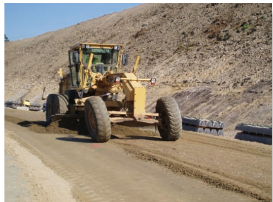
Refino para nivelar el suelo estabilizado
