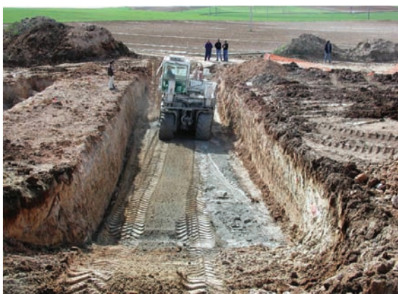
Estabilizado de la cimentación de una estructura en la línea Madrid-Valladolid
