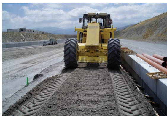
Estabilización de plataformas de los arcnos en la estación del AVE de Segovia
