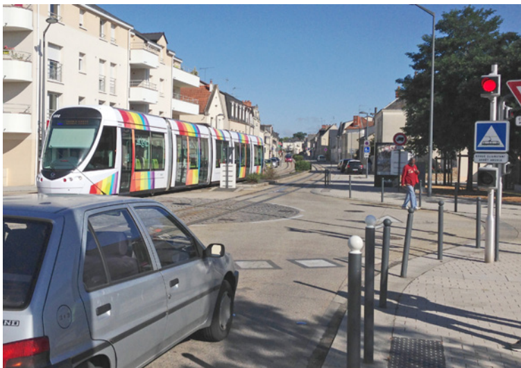
Photo 16 : sur ce mini-giratoire en entrée de site banal, la signalisation lumineuse pour les véhicules ne peut être implantée qu'aux entrées (source STRMTG)
