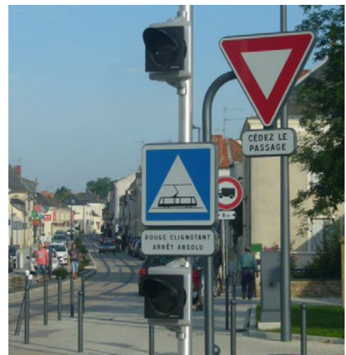
Photo 15 : les signaux R24 en barrage sont doublés en hauteur pour favoriser leur perception (source STRMTG)
