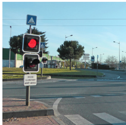
Photo 21 : le signal R24 est implanté à moins de 2,20 mètres puisque il n'est pas sur un espace emprunté par les piétons (source Cerema)
