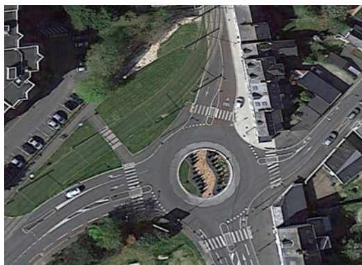
Photo 6 : traversée piétonne à proximité du giratoire
