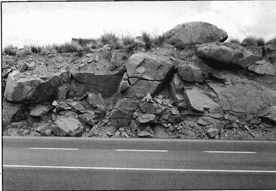
Figura 3.54.- Talud de baja altura excavado en las granodioritas del grupo 001. Puede apreciarse cómo el diaclasado origina bloques y cuñas de dimensiones variables. Kilómetro 97 de la carretera N-501 (Hoja 506-2).
