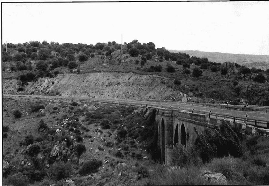
Figura 3.55.- Talud de altura media realizado en "jabre granítico". Osérvase cómo las rocas aflorantes, situadas en la ladera por encima del talud, "flotan" en la masa de suelo residual. Kilómetro 96,8 de la carretera N-501 (Hoja 506-2).
