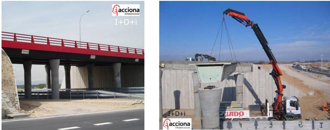
**Figura 3.29:** Aplicación de materiales compuestos en viaducto carretera M-111, Madrid.
