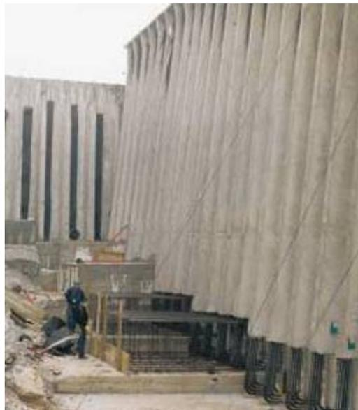
**Figura 2.9:** Muro de pantalla prefabricada y zapata in situ.
