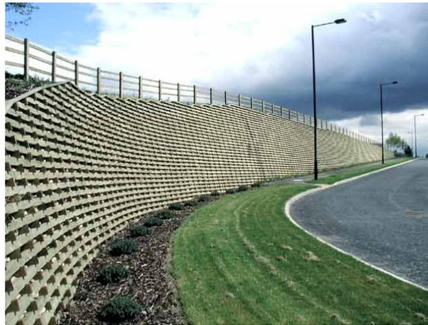
**Figura 2.5:** Muro de contención tipo cribas.
