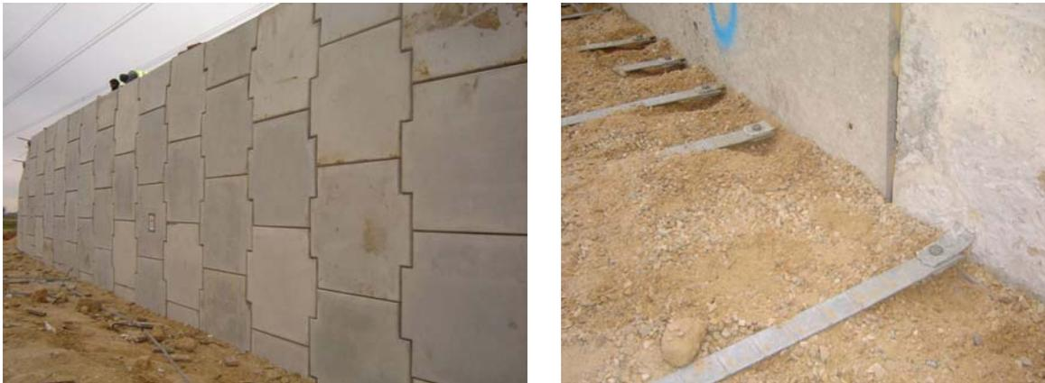
**Figura 2.13:** Muro de Tierra Armada y sistema de conexión para tiras de refuerzo.
