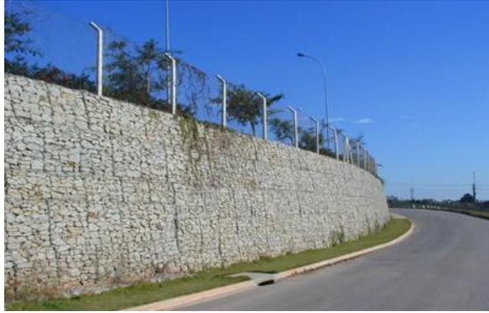
**Figura 2.6:** Muro de contención de gaviones.
