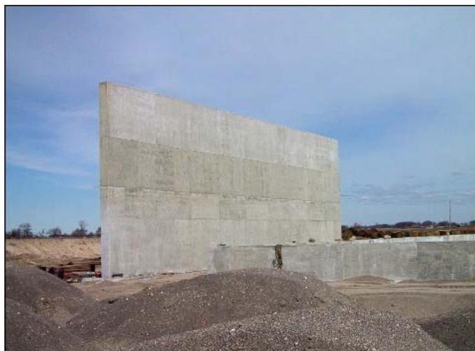
**Figura 2.8:** Muro de contención tipo ménsula.
