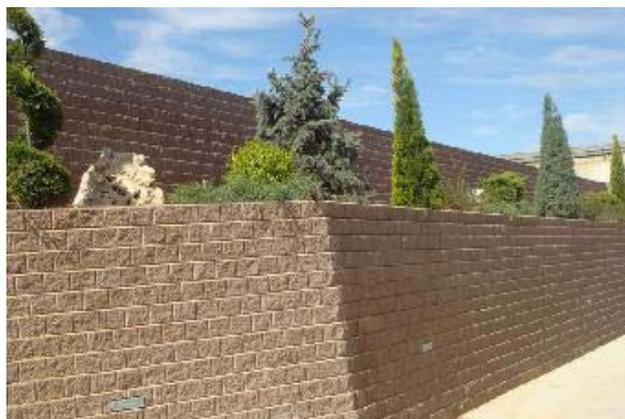
**Figura 2.11:** Muro de bloques prefabricados de hormigón.
