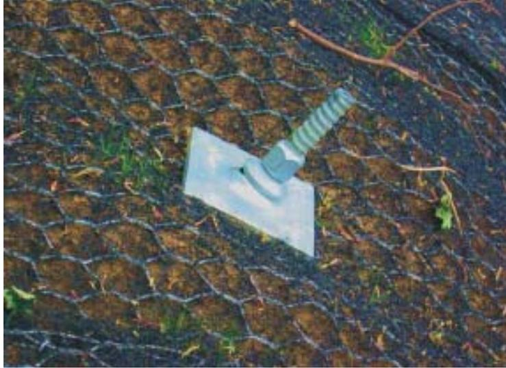
**Figura 3.35:** Anclaje fabricado en FRP's para la contención de un talud.
