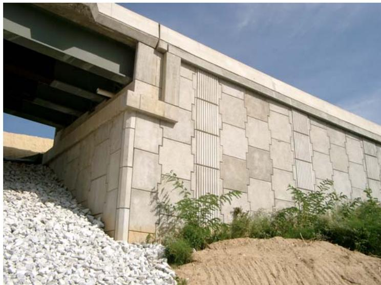
**Figura 1.3:** Aplicación de muro de tierra mecánicamente estabilizada.
