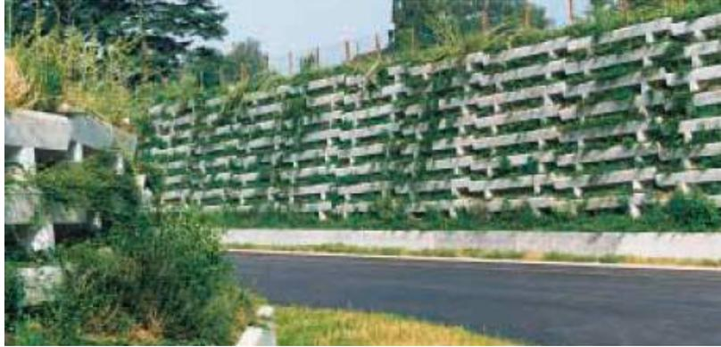
**Figura 2.10:** Muro de módulos prefabricados verdes.
