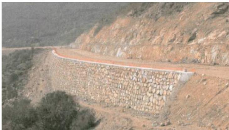
**Figura 2.7:** Muro de contención de escollera.
