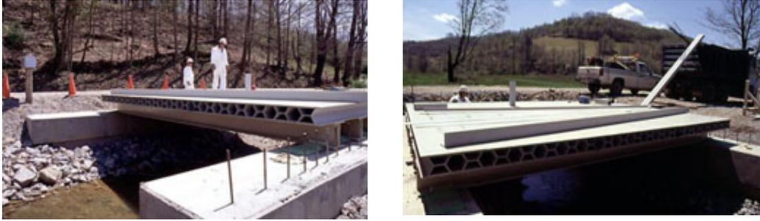
**Figura 3.26:** Aplicación de materiales compuestos en puente Wichwire Run en West Virginia, EEUU.
