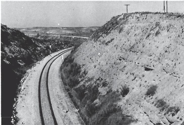
Fig. 17. Talud en areniscas de la formación 33 a en Gumiel de Hizán
