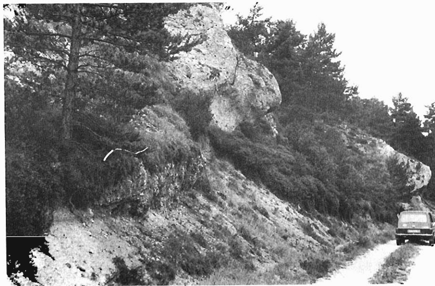
Foto 58.— Taludes verticales y coluviones granulares en el Pontense de Bóveda
