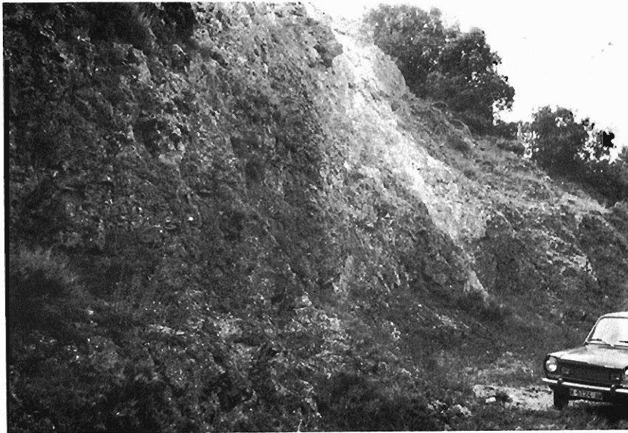
Foto 65.— Frente abandonado de explotación en las carniolas y calizas dolomíticas de Villatomil. Grupo 221.
