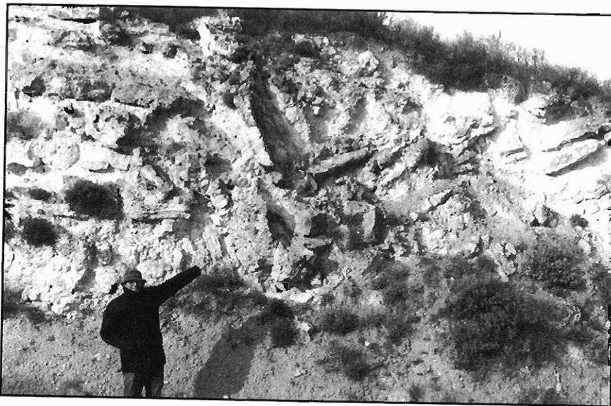
Foto 17.- Rotura gravitacional en el borde de la superficie del páramo. P.K. 50 de la carretera de Hornillos de Cerrato a Baltanás.
