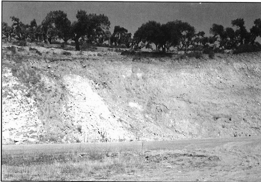
Figura 3.14.A.- Aspecto en época estival de un talud artificial de la carretera entre Aldehuela de la Bóveda y Garcirrey (Hoja 477-3), realizado en las arenas arcillosas del grupo (321), en contacto con un filón de aplita y con micacitas alteradas.
