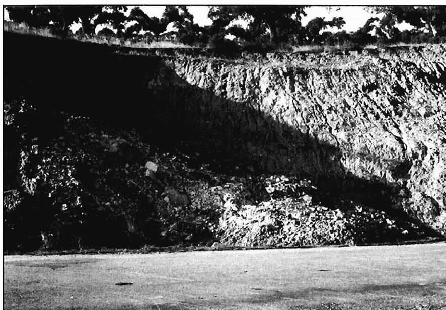
Figura 3.14.B.- Aspecto del mismo talud de la Figura 3.14.A durante la temporada invernal, y después de grandes lluvias. Comparando las dos figuras se observa la zona deslizada.
