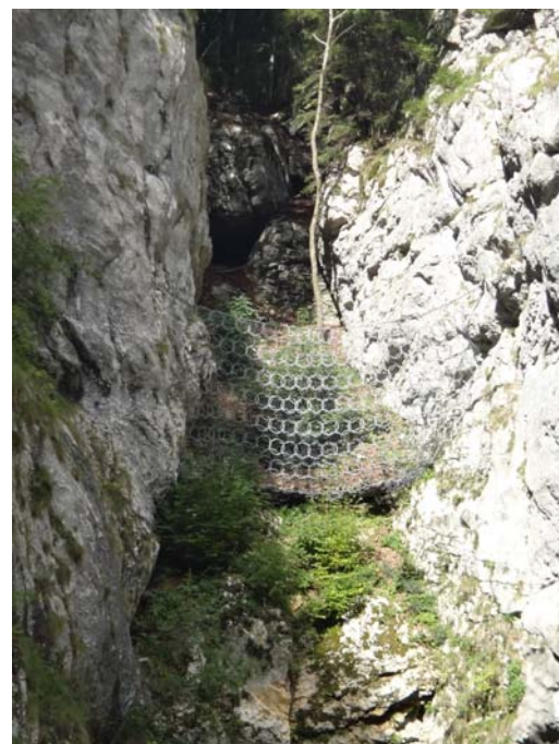
Figure 12. Ecran fixé à la paroi rocheuse en lieu et place des montants (Gorges de la Bourne, Isère, octobre 2012. Source : M. Bost, Ifsttar).
