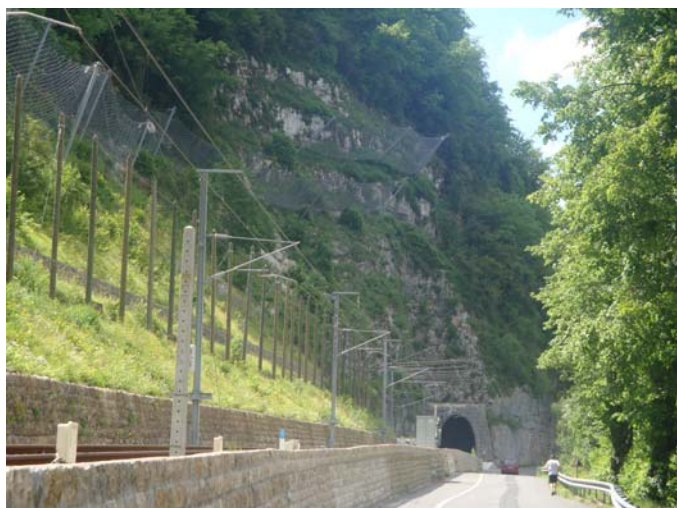
Figure 13. Chevauchement d'ouvrages (Ligne de train des Carpates, Ain, juin 2010. Source : M. Bost, Ifsttar).
