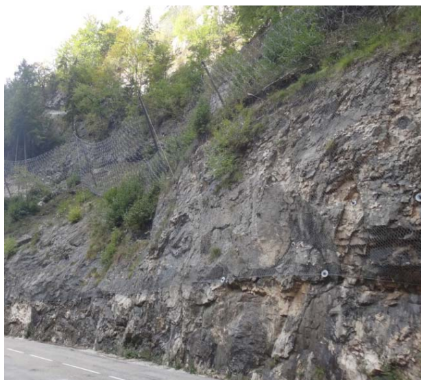
Figure 1. Ecrans de filet pare-blocs dynamiques (Gorges de la Bourne, Isère, octobre 2012. Source : M. Bost, Ifsttar).
