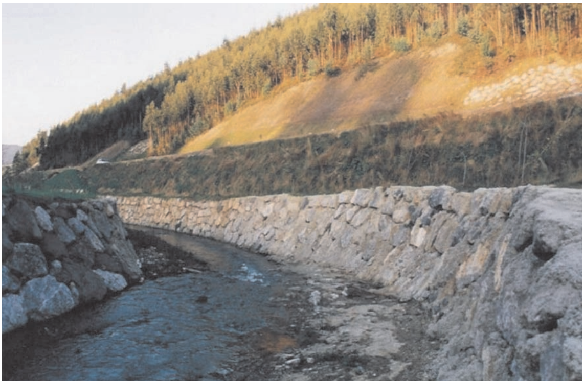
FIGURA 1.2. MURO DE ESCOLLERA EN UN ENCAUZAMIENTO FLUVIAL.
