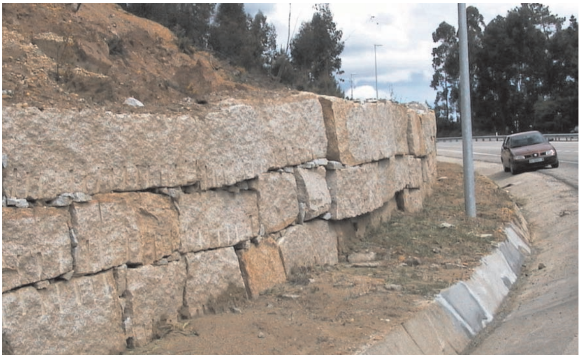
FIGURA 1.5. MURO DE CONTENCIÓN DE BLOQUES PARALELEPIPÉDICOS
