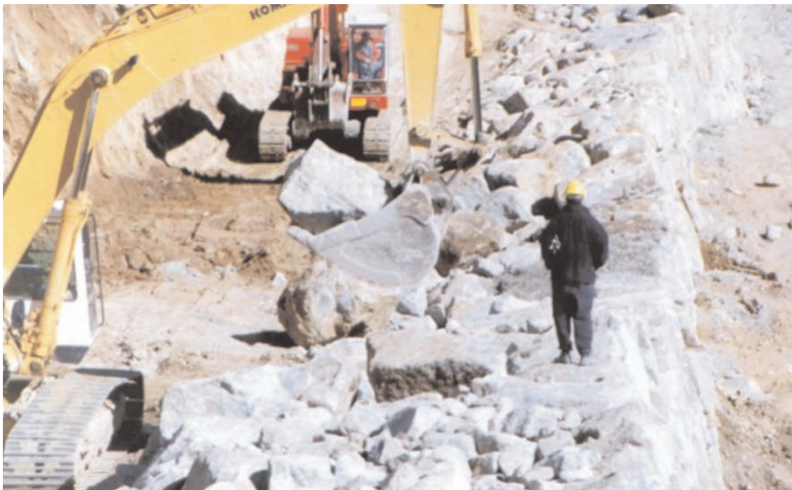
FIGURA 5.7. EJECUCIÓN MEDIANTE EXCAVADORA CON CAZO.
