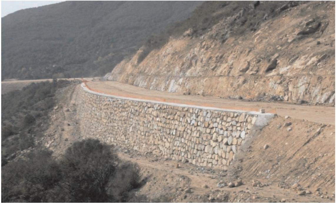
FIGURA 1.4. MURO DE SOSTENIMIENTO DE ESCOLLERA COLOCADA.
