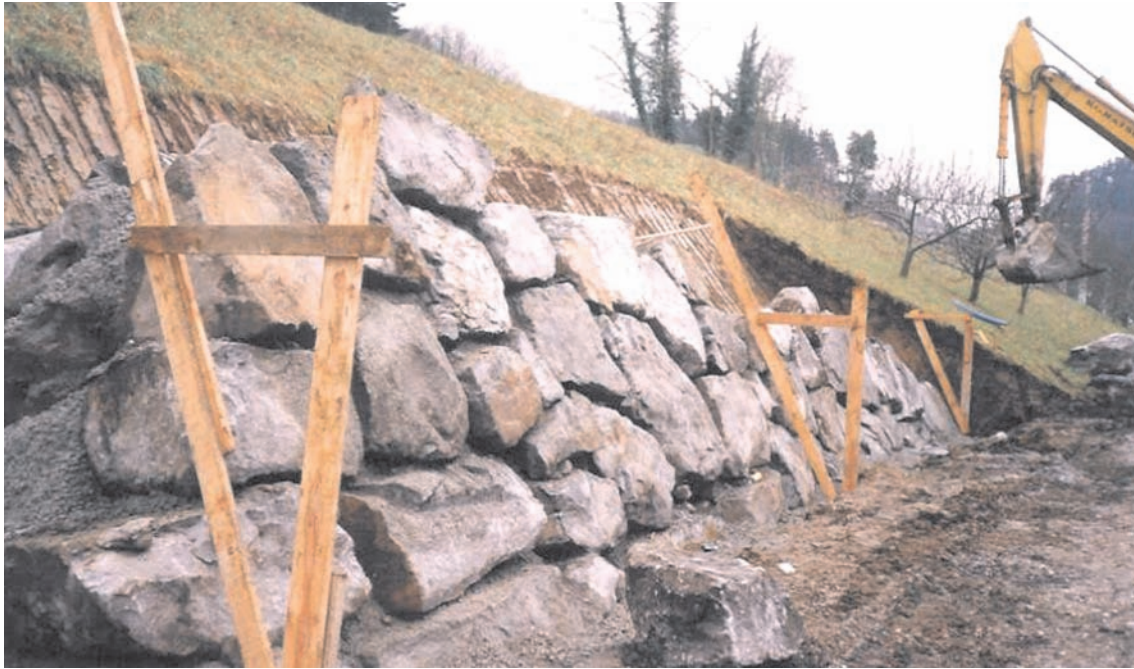
FIGURA 5.9. REFERENCIAS GEOMÉTRICAS PARA AYUDA DEL MAQUINISTA.
