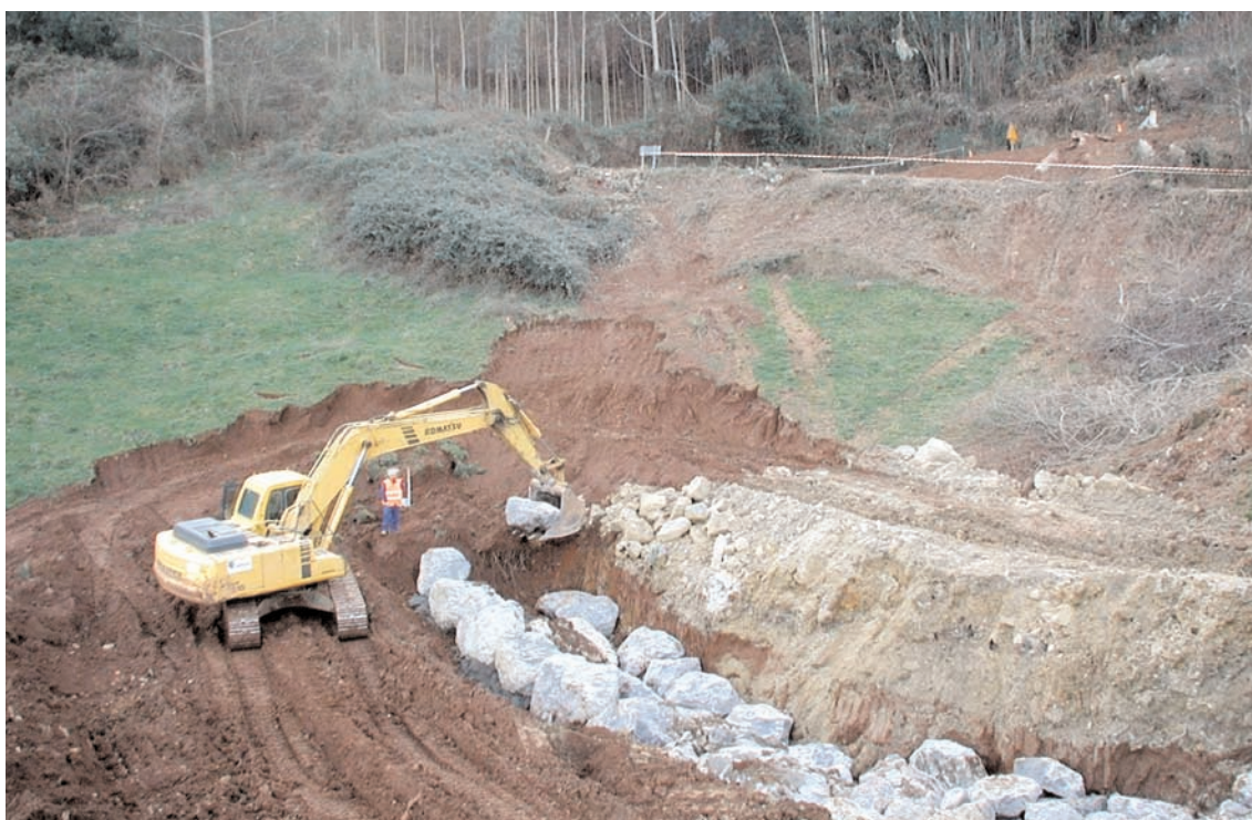
FIGURA 5.2. COLOCACIÓN DE BLOQUES EN EL CIMIENTTO.
