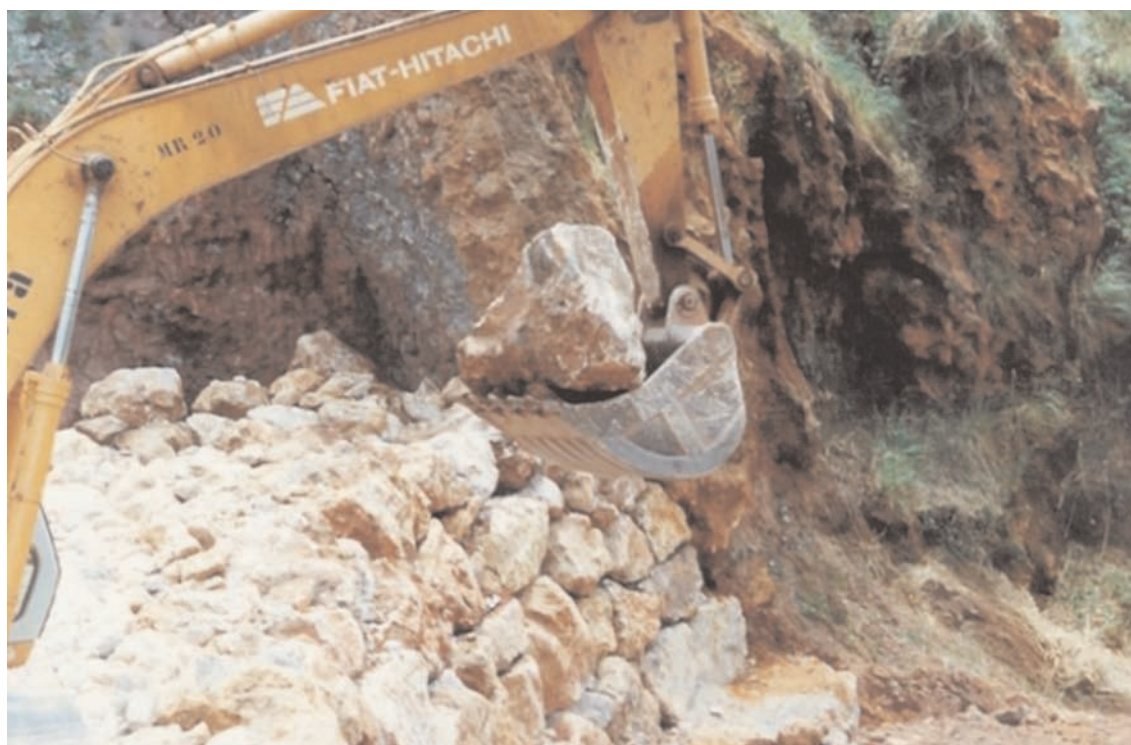
FIGURA A-1.1. EXCAVADORA CON CAZO.
