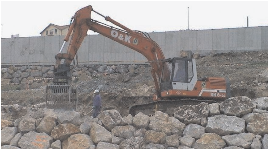
FIGURA 5.8. EJECUCIÓN MEDIANTE EXCAVADORA CON PINZA.
