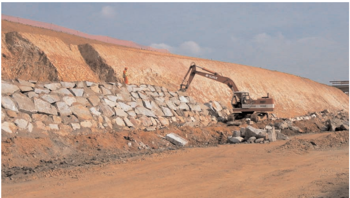
FIGURA 5.5. FORMACIÓN DEL CUERPO DEL MURO.
