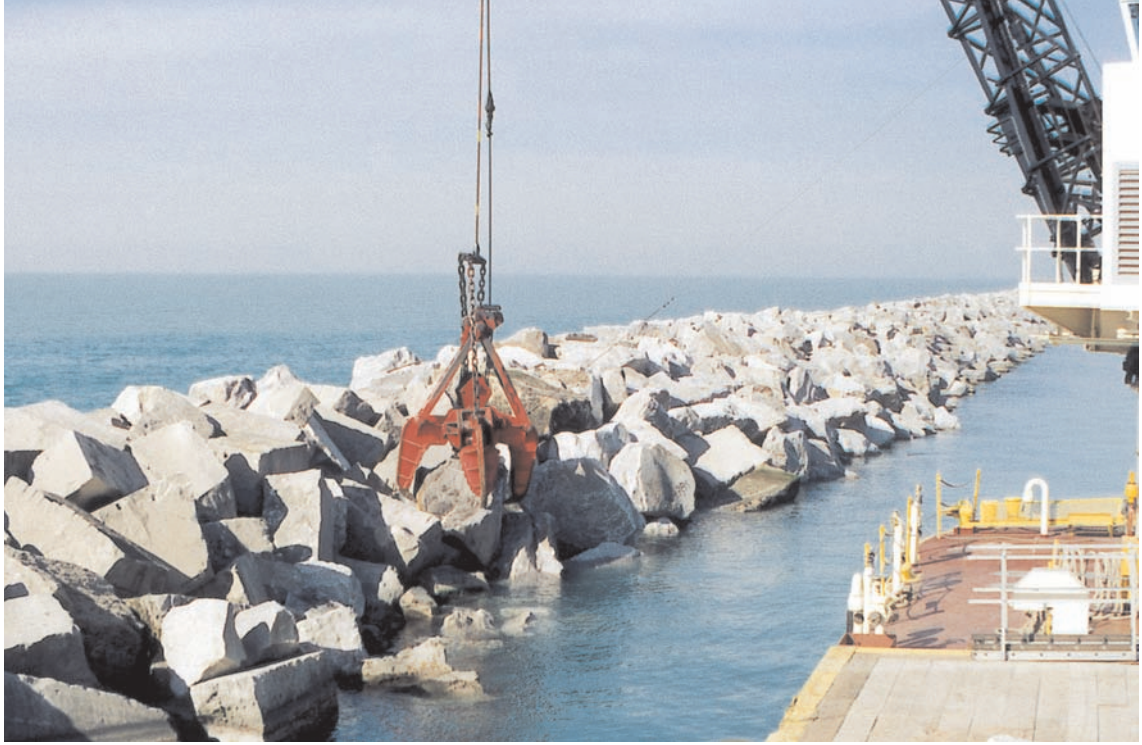
FIGURA 1.1. PUESTA EN OBRA DE ESCOLLERA EN UNA OBRA MARÍTIMA.
