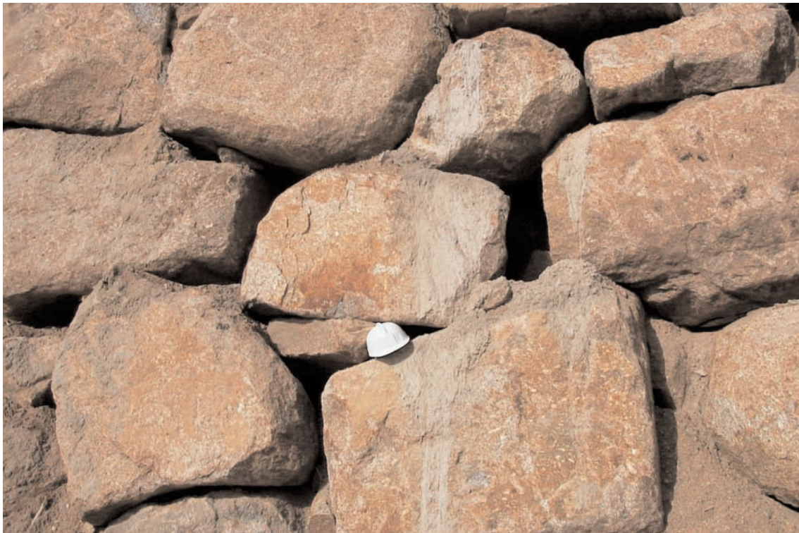
FIGURA 5.6. ENTRAMADO DE BLOQUES QUE EVITA LA FORMACIÓN DE FILAS Y COLUMNAS.
