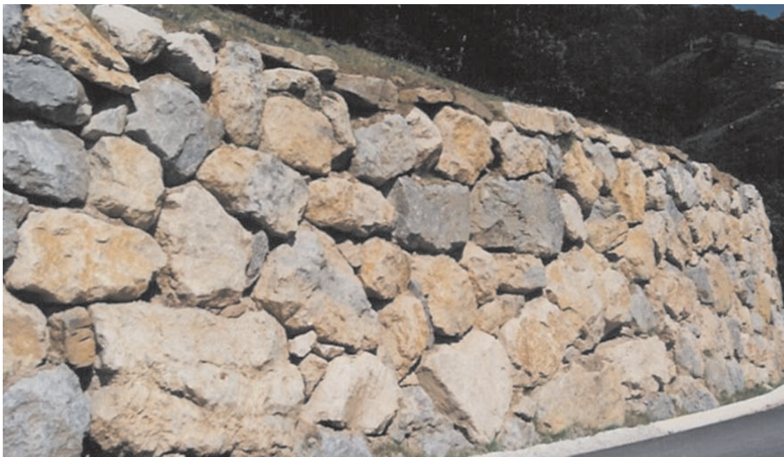
FIGURA 1.3. MURO DE CONTENCIÓN DE ESCOLLERA COLOCADA.
