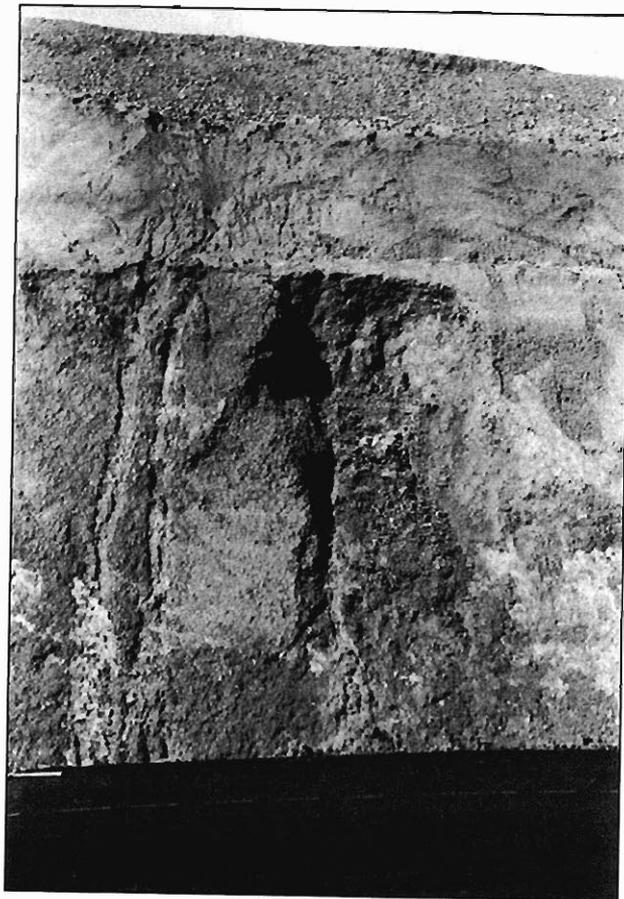
Fig. 4.3.— Pequeño deslizamiento producido en un talud del grupo 321a en la carretera N-120, en las inmediaciones de Ledigos.
