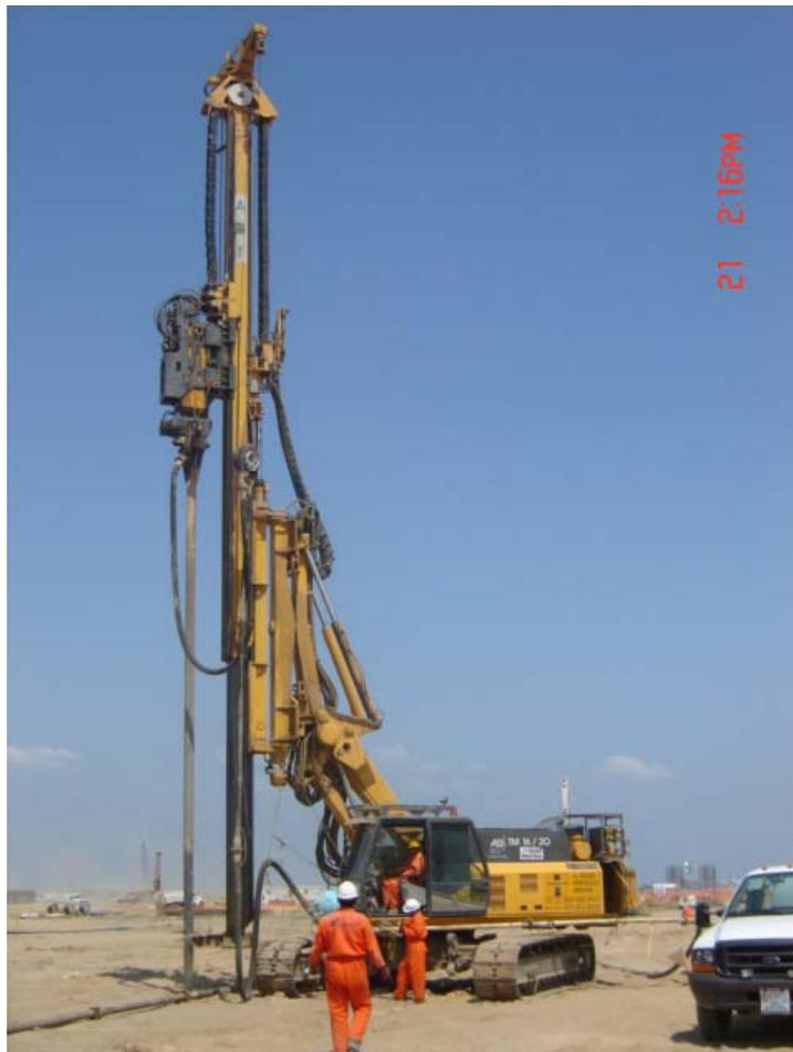
Foto VI-7 Equipo utilizado para la perforación e inyección de mortero.
