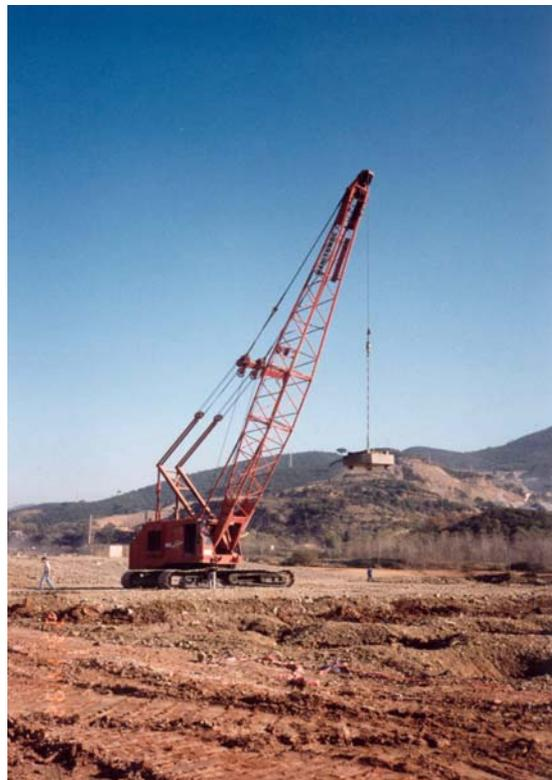
Foto III-1 Compactación dinámica clásica.
