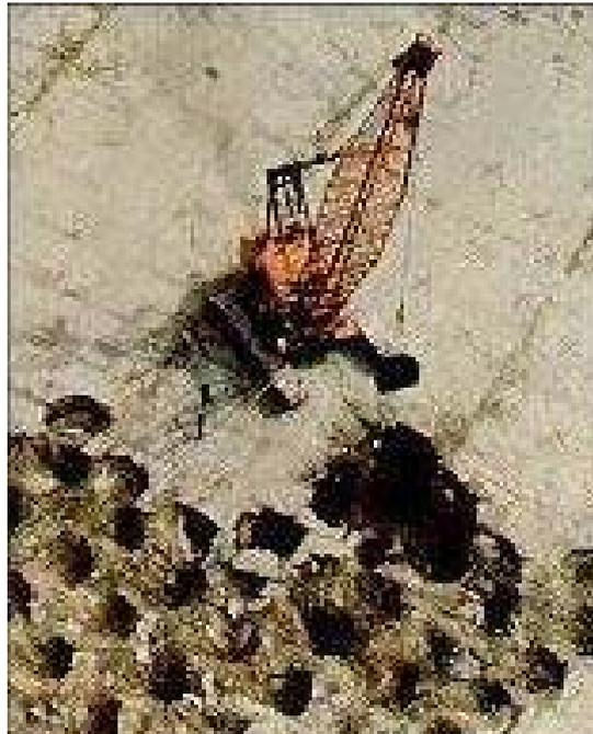
Foto III-2 Cráteres producidos en la aplicación de la compactación dinámica clásica.
