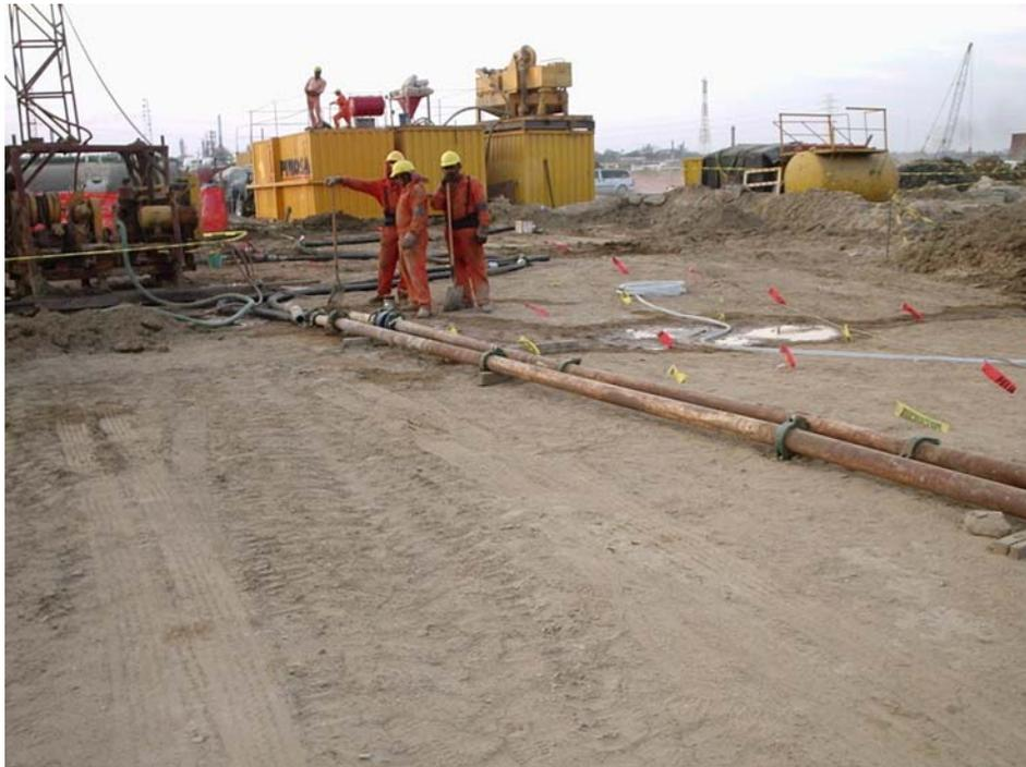
Foto VI-6 Tuberías de acero y mangueras de gomas utilizadas en los ensayos.
