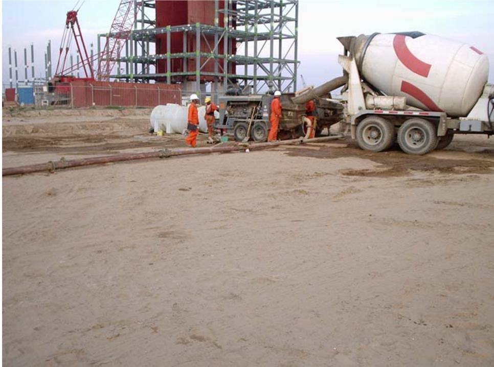
Foto VI- 4 Camión hormiguera y bomba utilizada en el ensayo.
