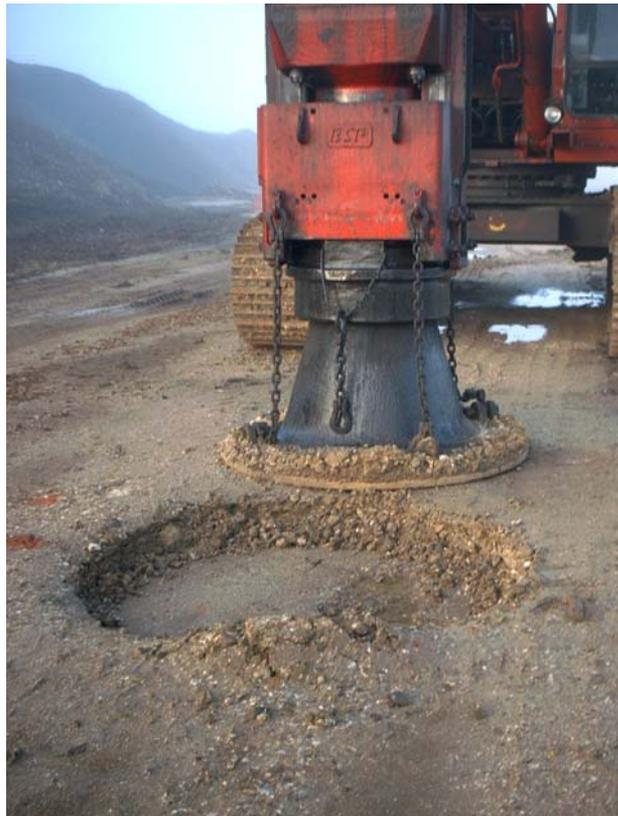
Foto III-4 Detalle de la zapata que recibe los impactos en la CDR.
