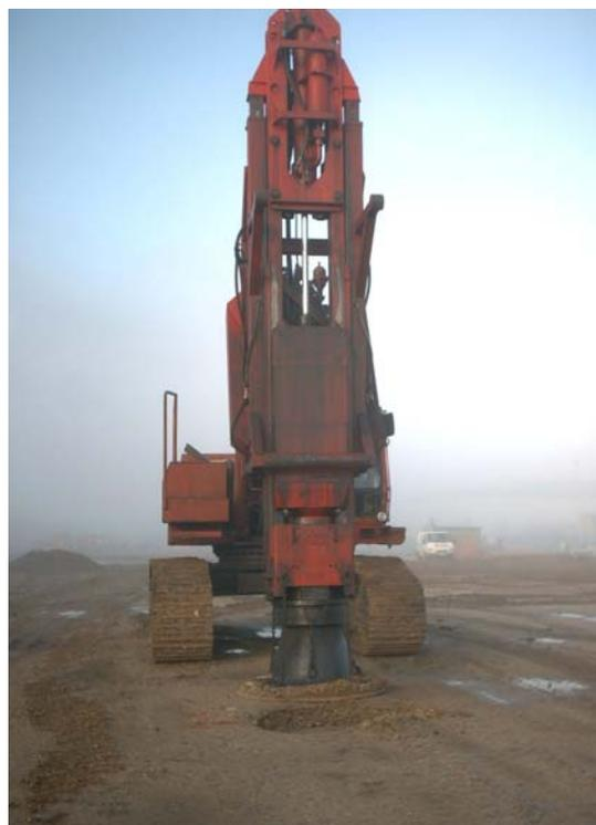
Foto III-3 Compactación dinámica rápida.
