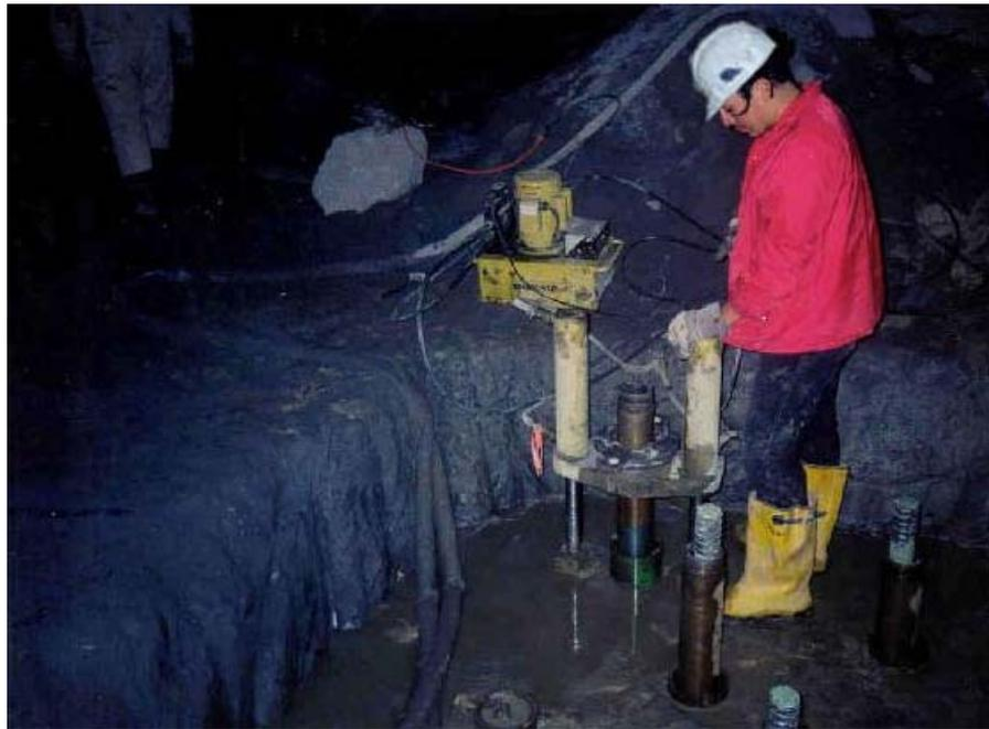
Foto IV-6 Extracción tubería de inyección con gatos (Armijo, 1997).
