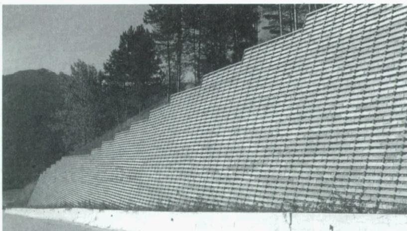
Fig. 8-1. Muro jardinera de madera. (TIMBACRIB)
