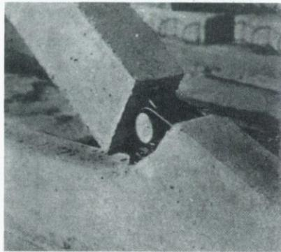
— Después de esta operación se sitúa la pantalla sobre el cordón de cimentación, calzándola mediante unas cuñas de madera, pudiéndose necesitar la ayuda de puntales para mantener la verticalidad de la misma. No existe ningún tipo de unión entre el alzado y el cordón de cimentación u hormigón de limpieza.
