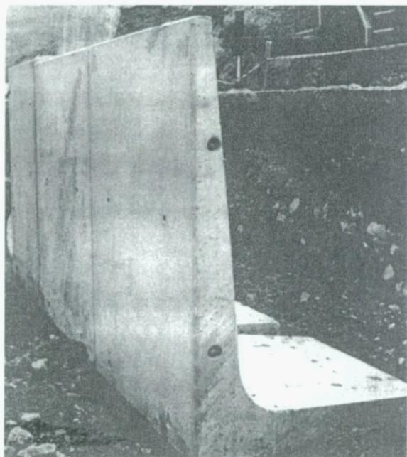
Fig. 9-8. Muros completamente prefabricados. (MUROL-ST)
