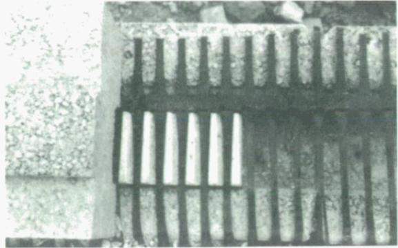
Algunos fabricantes ofrecen la posibilidad de obtener un muro abierto de bloques, es decir, con huecos en donde crece la vegetación. Esto origina en el muro una reducción de los esfuerzos capaces de resistir, así como una disminución de la altura máxima de muro que se pueda llegar a obtener.
