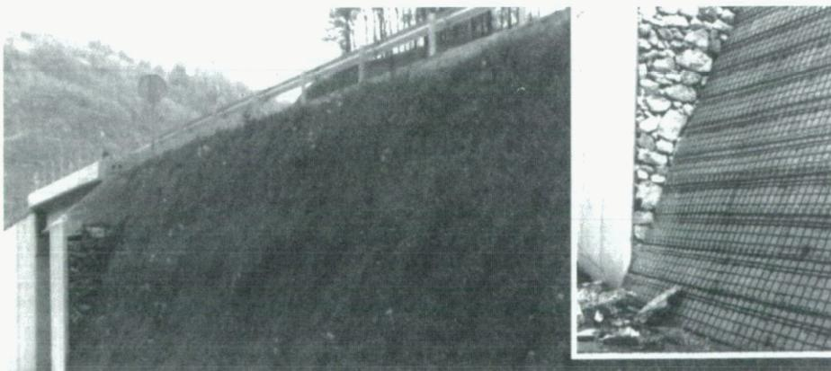
Fig. 6-1. Muro vegetado (Sistema TEXTOMUR)
