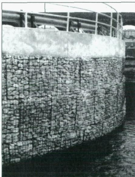
Fig. 7-1. Muro de gaviones
