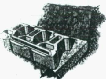
3. Vertido y compactación del relleno. Se produce el relleno tanto del trasdós como de los orificios interiores o alvéolos de las propias piezas.
