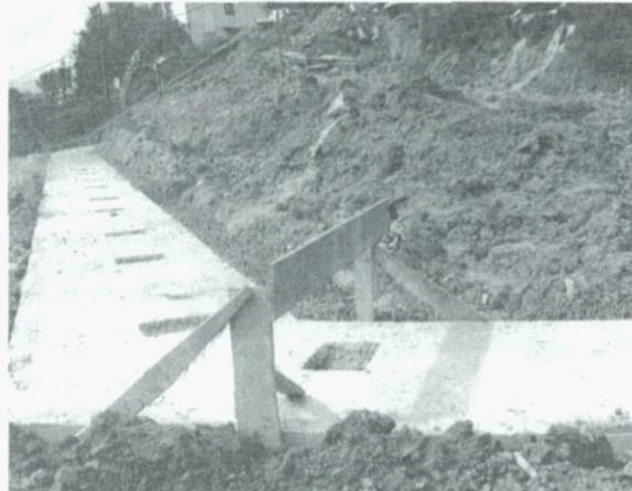
3. Sobre las zapatas se colocarán las piezas base prefabricadas, en caso de existir, correctamente alineadas y niveladas. Estas pueden ser recibidas con hormigón entre sí y con la zapata. Posteriormente, se colocará el sistema de drenaje.
