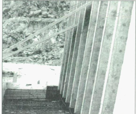
6. Hormigonado del zunchado en coronación, cuando exista. Se debe realizar antes del relleno y compactación del trasdós, evitándose de este modo los posibles desplazamientos, originados por el relleno, de las pantallas entre sí.
