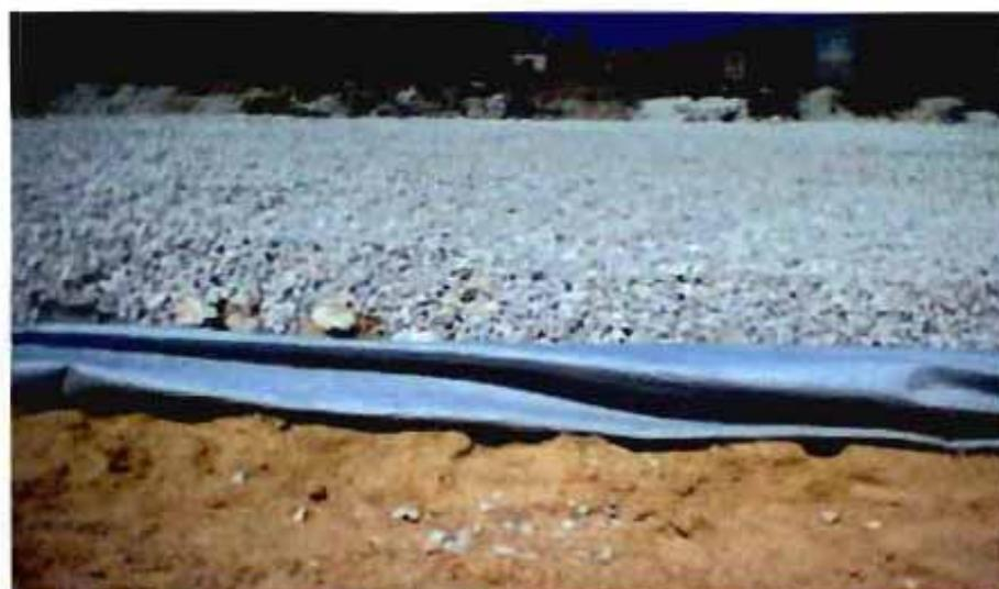
Geotextil de separación y filtro (Polyfelt).
