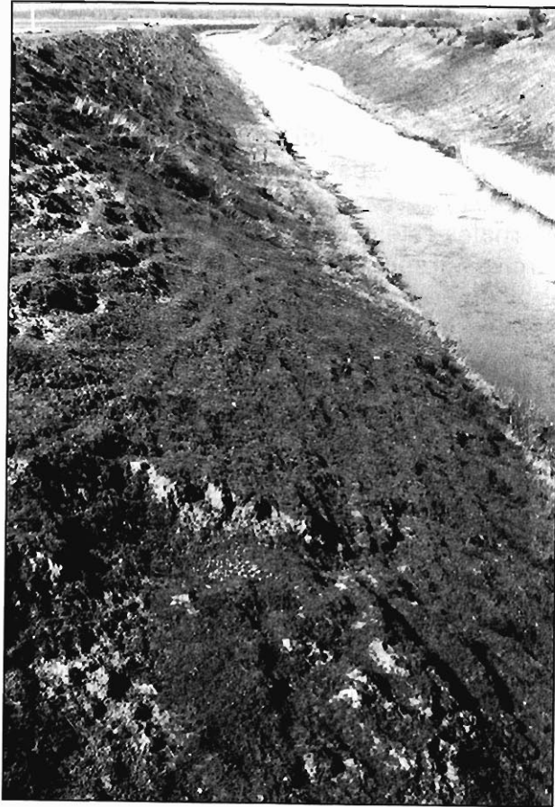
Foto 39.— Canal de Castilla en su cruce con la carretera local que enlaza los pueblos de Osornillo y Osorno. El cauce está excavado en arcillas y limos con intercalaciones arenosas, del grupo 321h. A pesar de lo tendido de sus taludes, se observa una inestabilidad generalizada de los mismos.
