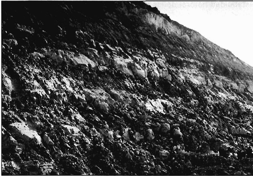
Foto 19.— Talud excavado en las margas y margo-calizas con horizontes intercalados arenosos, correspondientes al grupo 321e. Forma parte de las obras de mejora del trazado que se efectúan en la carretera N-120, a la altura del p.k. 143, y en la margen derecha del arroyo Perú. El agua surge en distintos niveles del desmonte, lo que implica que si este agua no se controla mediante un drenaje adecuado, provocará un deterioro rápido del mismo.
