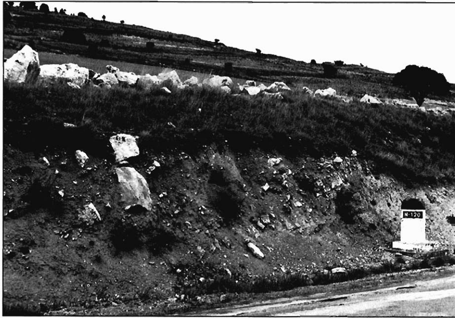
Foto 7.— Coluviones con bloques calizos procedentes de desprendimientos de las cornisas del páramo, sobre un sustrato calizo y margoso basculado, a consecuencia de una inestabilidad pretérita. Laderas de la margen izquierda del arroyo del Plantío, a la altura del p.k. 137 de la carretera N-120 según el Mapa General 1:50.000 del Servicio Geográfico del Ejército.
