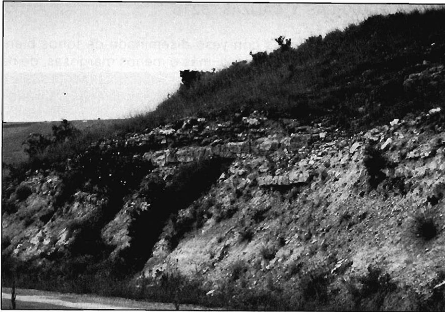
Foto 15.— Taludes de excavación en el grupo 321d, en la carretera que se dirige desde Pedrosa de Río-Urbel a Avellanosa, a un kilómetro aproximadamente de haber pasado el desvío que conduce a Lodoso.
