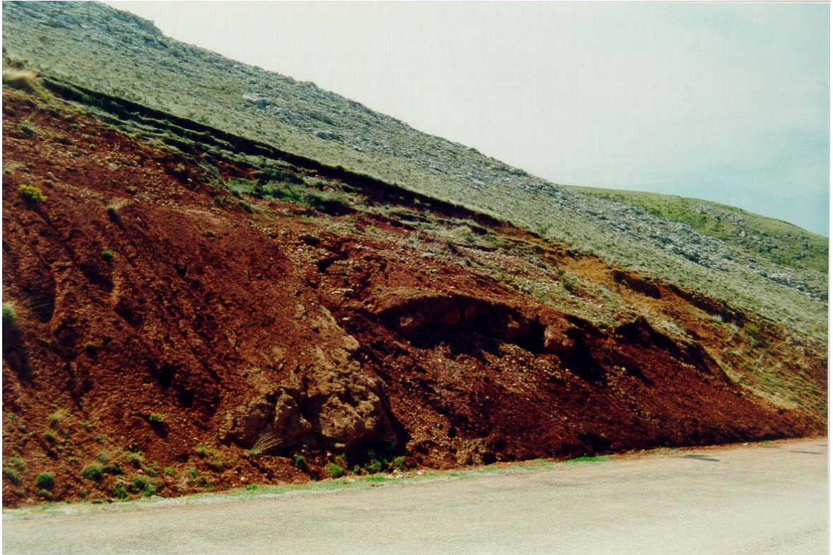
FOTO N° 26. Deslizamiento del talud situado en la carretera local de Villamartín de Villadiego a Amaya. En este punto afloran arcillas y conglomerados del grupo 300c.
