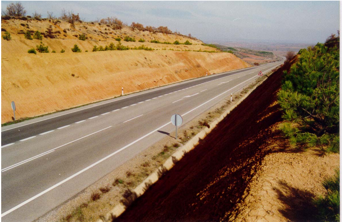
FOTO N° 19. Desmonte en los fangos de la Facies Grijalba-Villadiego (Grupo 300a) situado en el P.K. 72+000 de la carretera N-611. Los taludes alcanzan alturas de hasta 15 m y pendientes de 45°.
