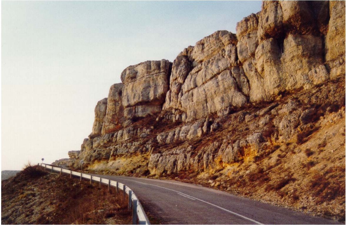
FOTO N° 39. Escarpe en el que afloran los potentes bancos calcáreos del Cretácico Superior (grupo 232c). Los planos de estratificación y fractura individualizan grandes bloques que por efecto de la erosión diferencial pueden verse inestabilizados.
