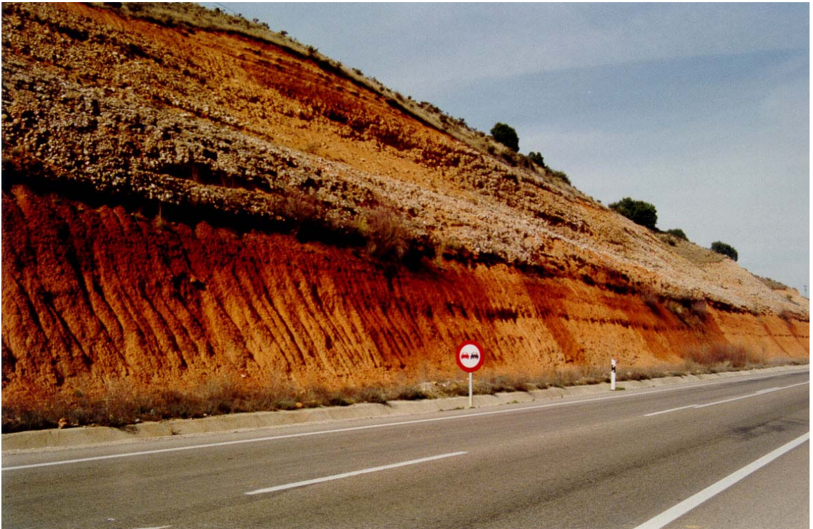
FOTO Nº 12. P.K. 89+000 de la carretera N-611. En el talud afloran los conglomerados del grupo 321a sobre los fangos del grupo 300a. Existe un acuífero colgado cuyas aguas fluyen por el contacto entre ambas formaciones.
