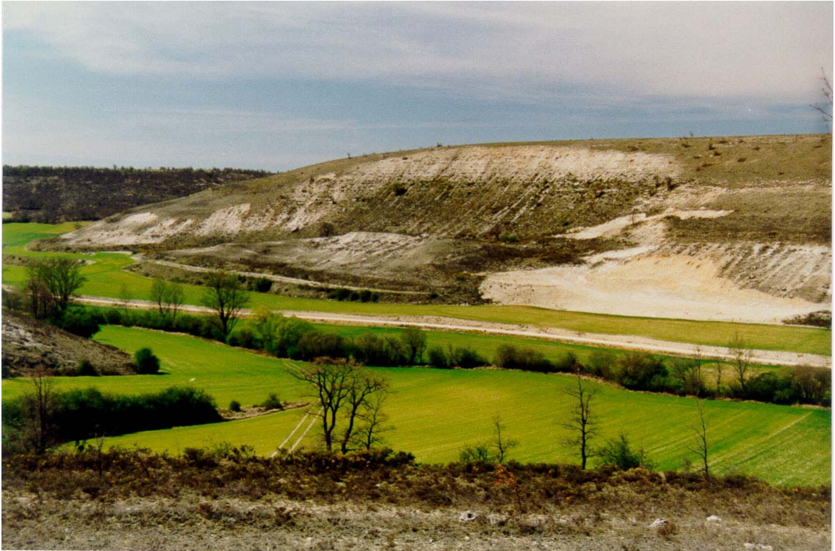
FOTO N° 7. Deslizamiento circular en una ladera del río Ruyales, al N de Avellanosa del Páramo. El deslizamiento afecta a las margas de la Facies Cuestas (Grupo 321e), y el escarpe del mismo se sitúa en la unidad superior, compuesta por una alternancia de calizas y margas (Grupo 321c).
