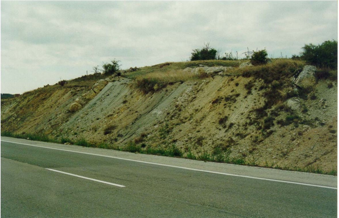
FOTO N° 49. Desmonte situado en el P.K. 114+500 de la N-611. En el talud afloran alternancias decimétricas a métricas de arcillas, lutitas, areniscas y niveles de calizas, pertenecientes al tramo detrítico/carbonatado de la F. Purbeck (grupo 230c).
