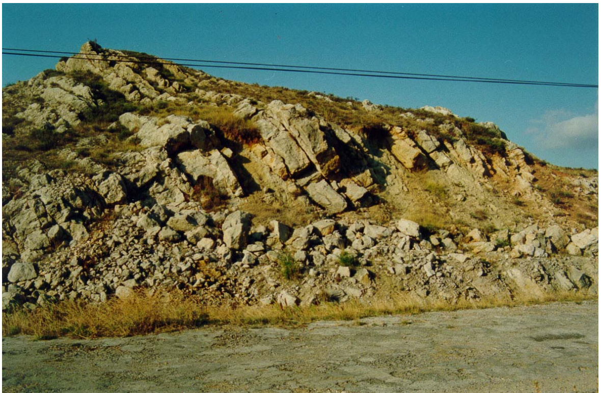
FOTO Nº 50. Desmonte situado en el P.K. 3+000 de la carretera Aguilar-Burgos, próximo a la estación de Aguilar. Afloran alternancias de calizas y lutitas del grupo 223a, perteneciente al tramo detrítico/carbonatado de la F. Purbeck.
