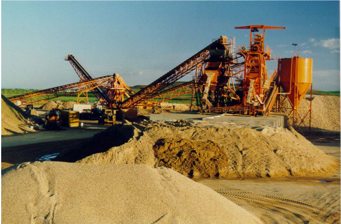
FOTO N° 62. Planta de clasificación y machaqueo situada en el P.K. 77+750 de la carretera N-611, sobre una terraza fluvial del río Pisuerga explotada de forma intermitente (Yacimiento YG-17).
