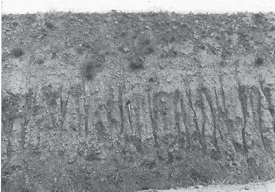
Fot. 35. Taludes artificiales en el grupo 350 a.
