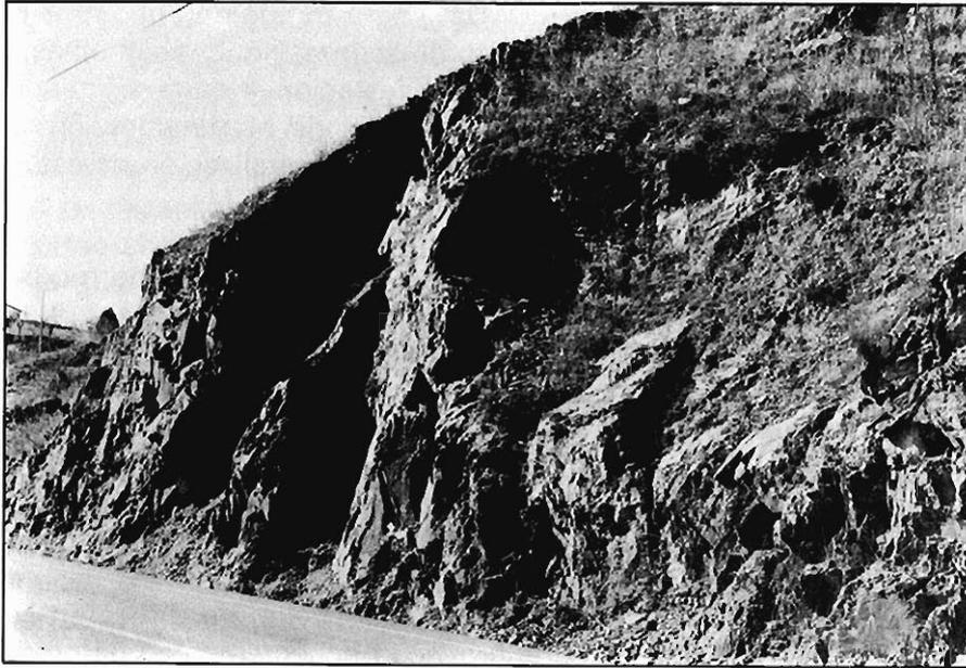
Foto 30.— Talud excavado en materiales del grupo (010a1). En el paramento pueden observarse las huellas de grandes cuñas desplomadas.
