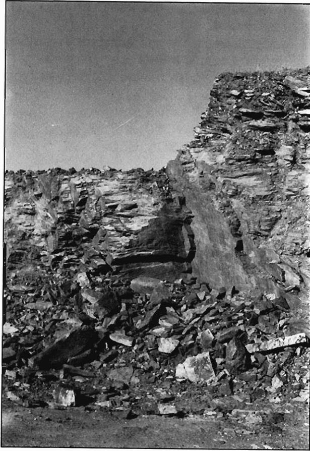
Foto 38.— Talud de excavación en la nueva carretera de circunvalación de Salamanca por el Oeste. Pizarras del grupo 121c. Se puede observar una clara problemática de inestabilidad de bloques y cuñas.
