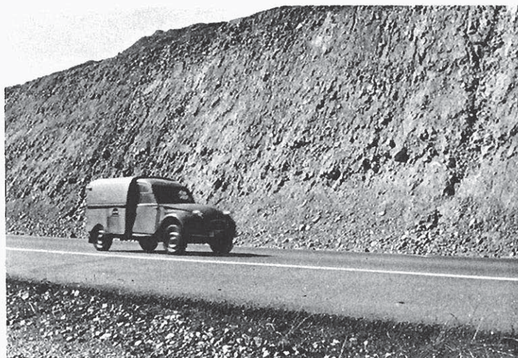
Foto 3-32 — Talud de la N-VI en materiales (32c).
