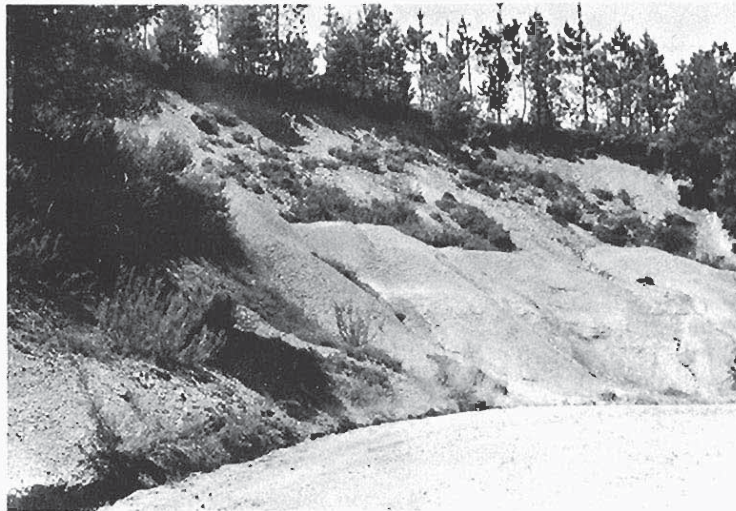
Foto 3-31 — Deslizamiento sobre la carretera de Brañuelas en la N-VI. (32b).
