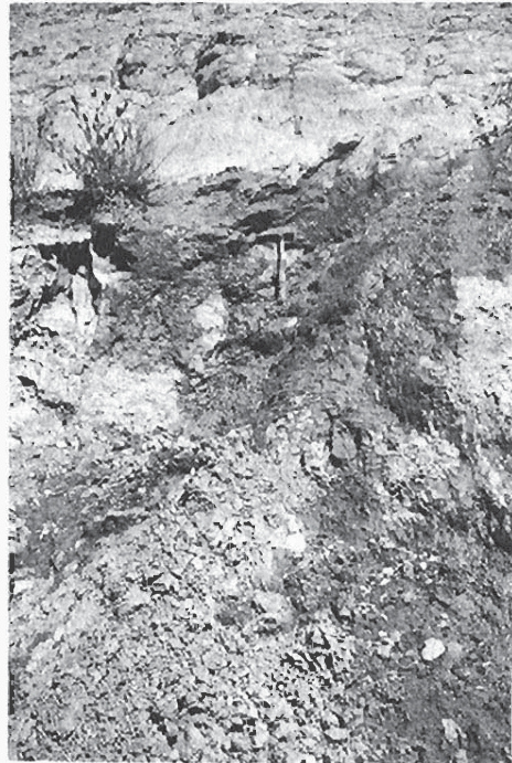
Foto 3-34 — Rezume de agua a través de un nivel arenoso en un talud sobre el grupo 32a (vista general y detalle).
