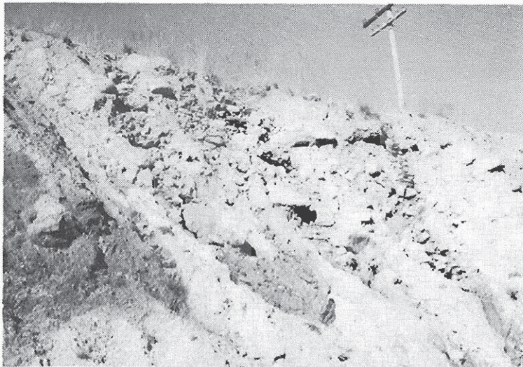
Fig. 8. Detalle de los coluviales de Somosierra que aparecen entre los kilómetros 94 y 95 de la C. N.-1
