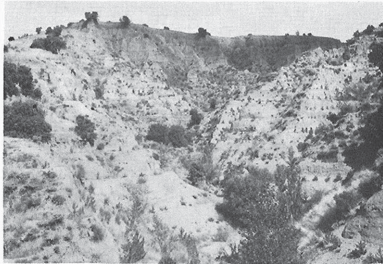
Fig. 19. Talud de unos 50° de pendiente continua y unos 15 metros de altura en el kilómetro 111 de la C. N.—1
