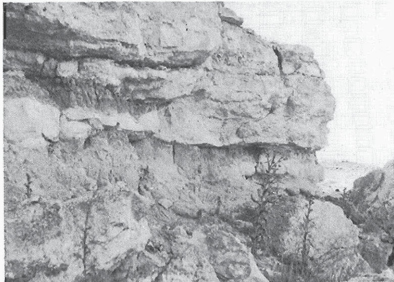
Fig. 48. Basculamiento de los bloques de caliza del páramo, por alteración de las margas de la base. Margen izquierda de la carretera a Pardilla
