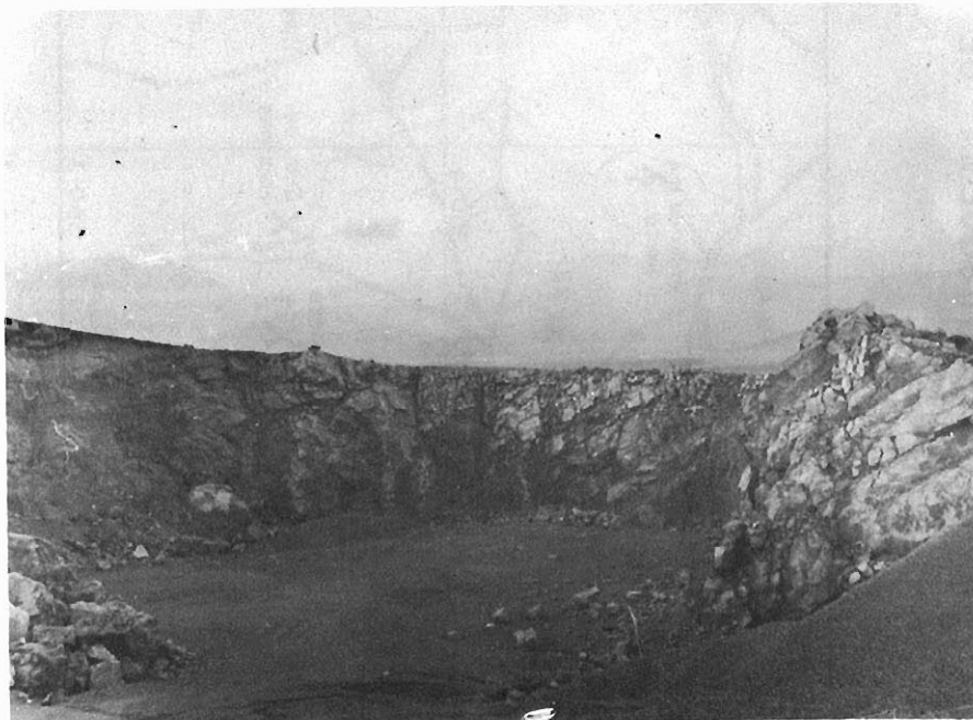
Foto 88.— Cantera en explotación en los materiales del grupo (223 e), situada a la altura de P. Km. 4 de la carretera de Soria a Logroño y Pamplona.
