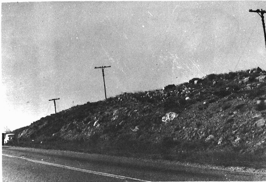
Foto 77.— Corte artificial sobre los materiales del grupo (221 g) en el P.K. 230 de la carretera Soria–Zaragoza.
