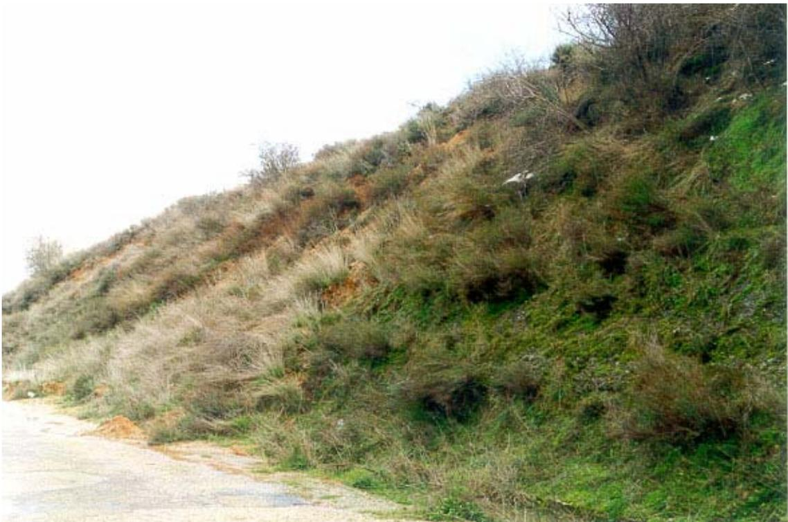
*Figura 3.23. Deslizamientos en un talud excavado en las gravas arcillosas del grupo litológico (321a), localizado en una curva abandonada de la carretera N-630, hacia la cola del embalse de Ricobayo.*
