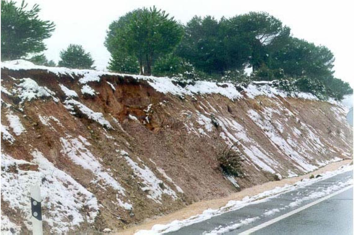
Figura 3.12. Talud excavado en los esquistos silíceos del grupo (121a), en el P.K.466,950 de la carretera N-122. La inestabilidad que se observa en la cabecera del talud se debe a la erosión de los materiales terciarios del grupo (311a), que recubren a los esquistos.
