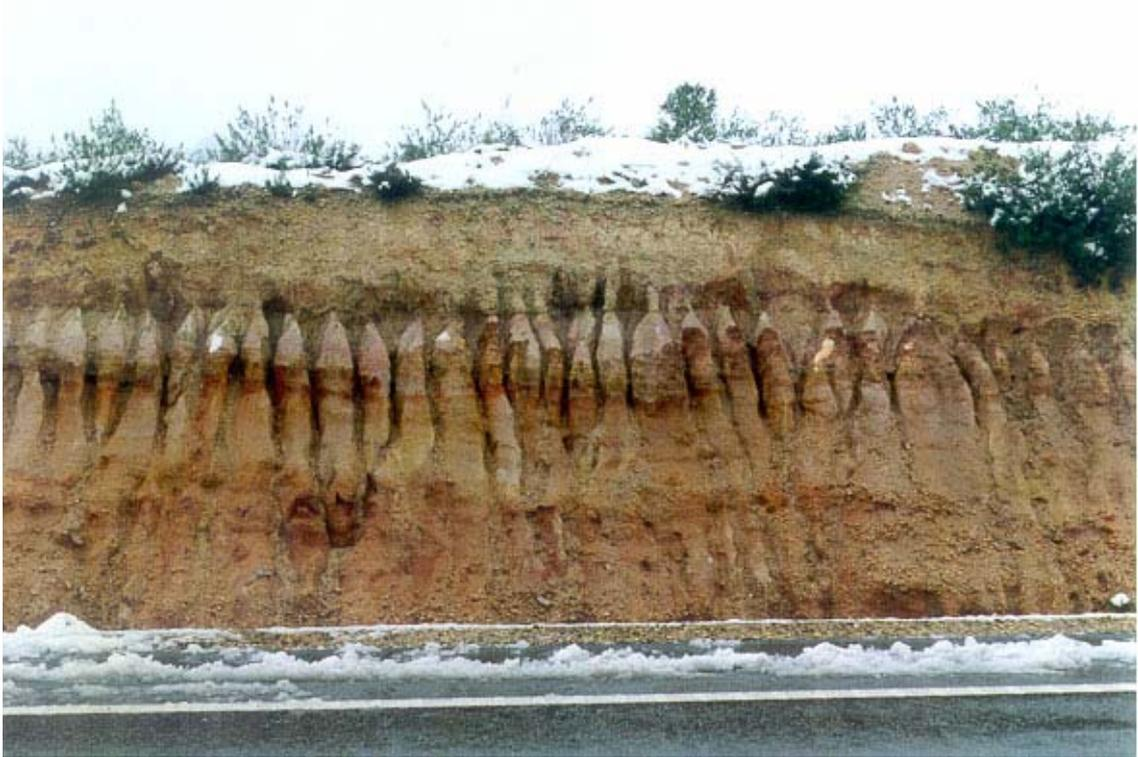
Figura 3.40. Detalle de la erosión en un talud excavado en los materiales del grupo (311a), situado en el P.K.466+500 de la CN-122.
