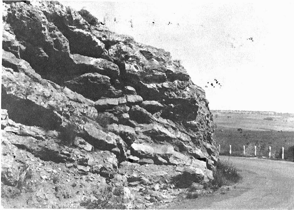
Foto 7.— Aspecto parcial del talud excavado en calcarenitas del Cretácico Superior (232a), en la carretera de Villacastín a Segovia
