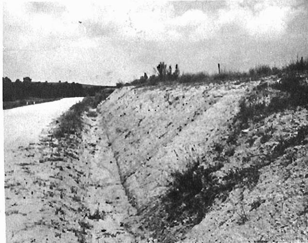
Foto 21.— Talud artificial, bien conservado. Sobre los depósitos arcóicos miocenos (321)
