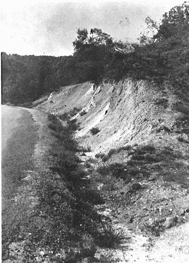
Foto 9.— Aspecto parcial del talud excavado sobre la formación arenó-arcillosa del Cretácico Inferior en la carretera de Villacastín a Segovia.
