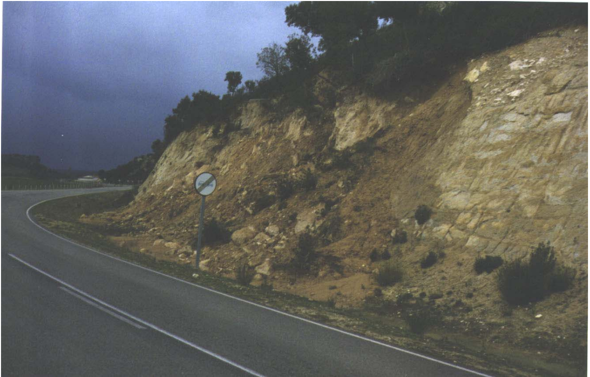
Figura 3.51. Talud de altura media realizado en el granito del grupo (001), en las proximidades de El Arco (Hoja 452-4).
