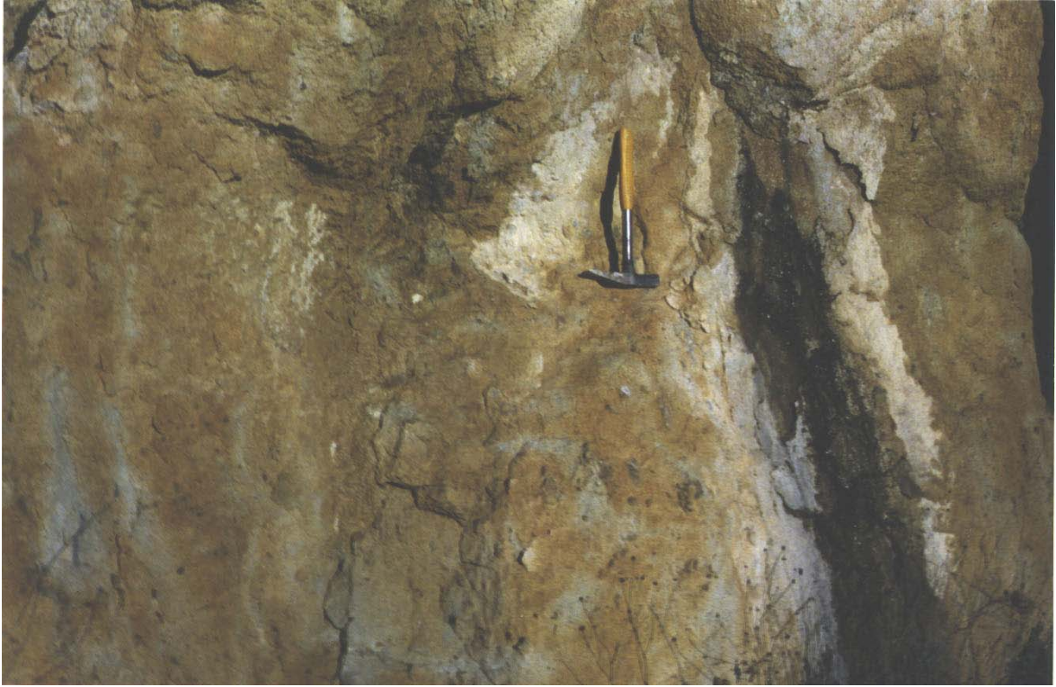
Figura 3.25. Areniscas del grupo (312c), en las proximidades de la localidad de El Piñero (Hoja 397-2). Puede observarse cómo el agua rezuma a través de una fisura.
