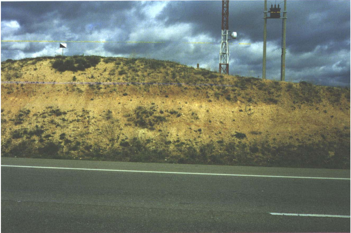
Figura 3.20. Aspecto de las costras carbonatadas que forman el grupo (313c), en un talud próximo al p.k. 325 de la carretera N-630 (Hoja-452-3).
