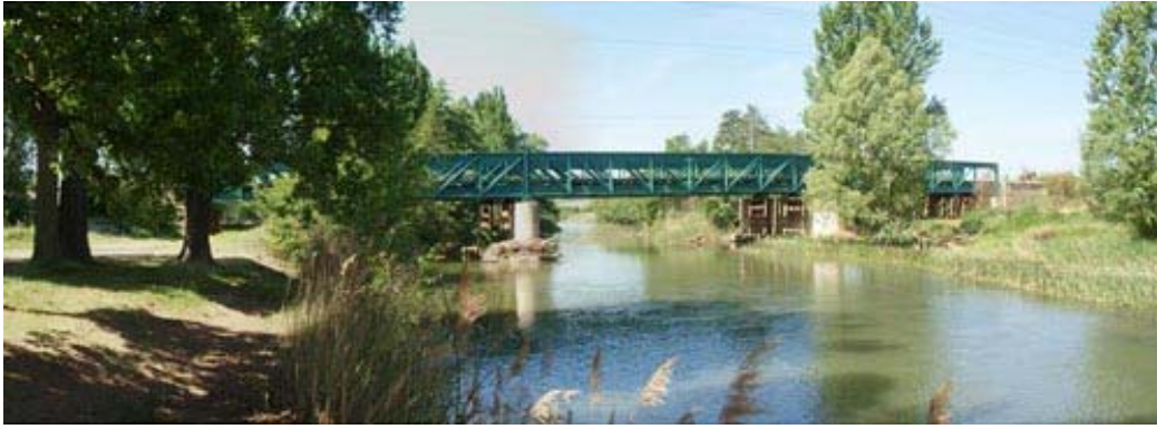
Ilustración 5. Panorámica ampliada del puente sobre el Carrión, ubicado muy cerca del núcleo urbano de Palencia
