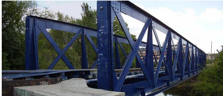
Link 5. Celosía en cruz de san Andrés del puente de Guardo
