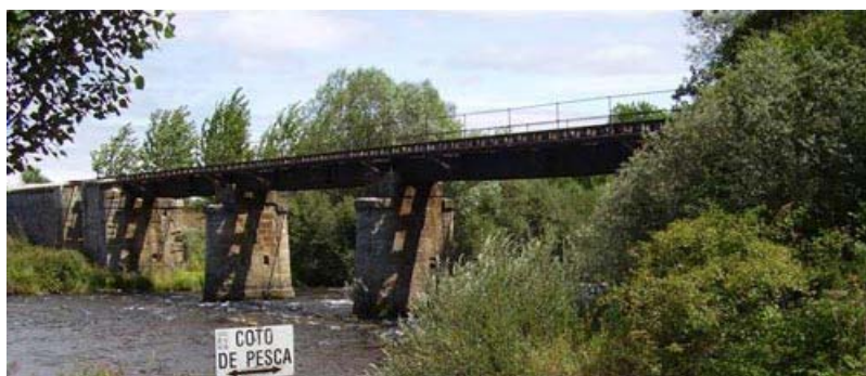
Ilustración 10. Puentes sobre el Pisuerga, en el Ferrocarril Bilbao-La Robla
