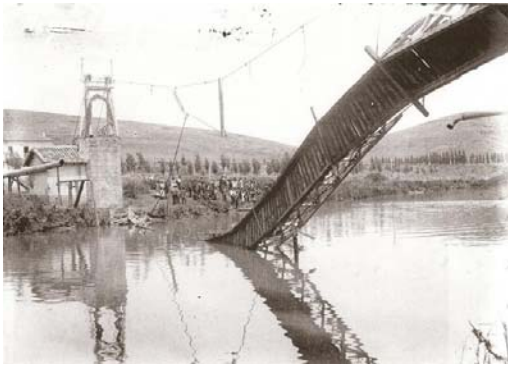
Imagen de la pasarela sobre el río Pisuerga tras su colapso en 1927
