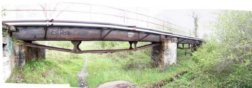
Link 8. Panorámica del puente sobre el río Cerneja
