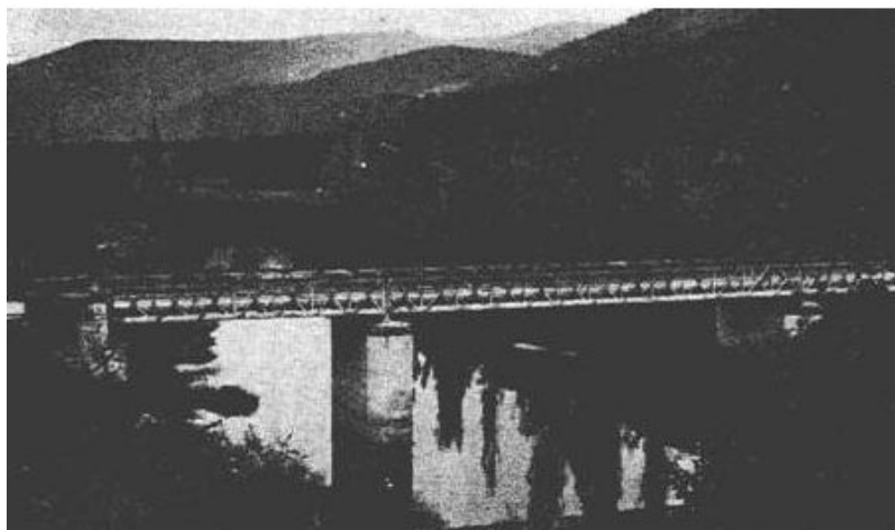
Link 3. Fotografía con el alzado del puente de Trespaderne a principios del siglo XX
