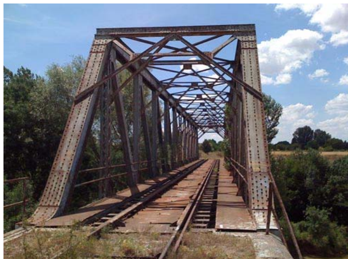
Ilustración 6. Aspecto en “cajón” de la sección transversal del puente de Vadocondes sobre el río Duero
