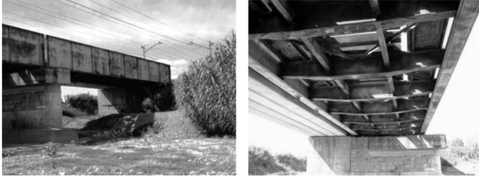
Figura 3.10 Puente de ferrocarril de la línea Valencia-Tarragona sobre Río Ana
