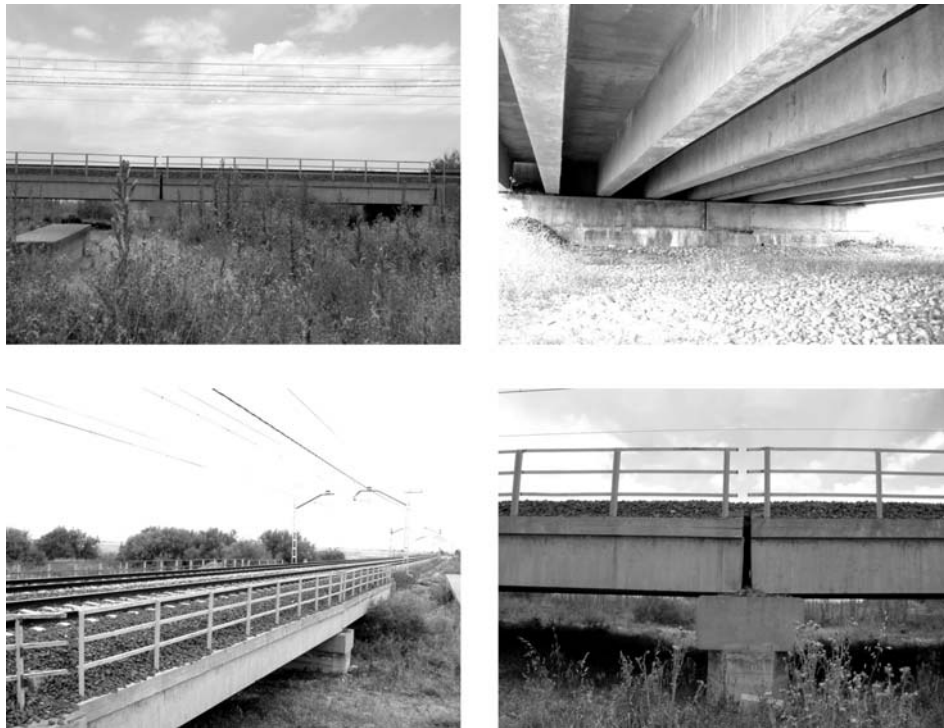
Figura 7.57 Imágenes del puente sobre el Río Guadiana
