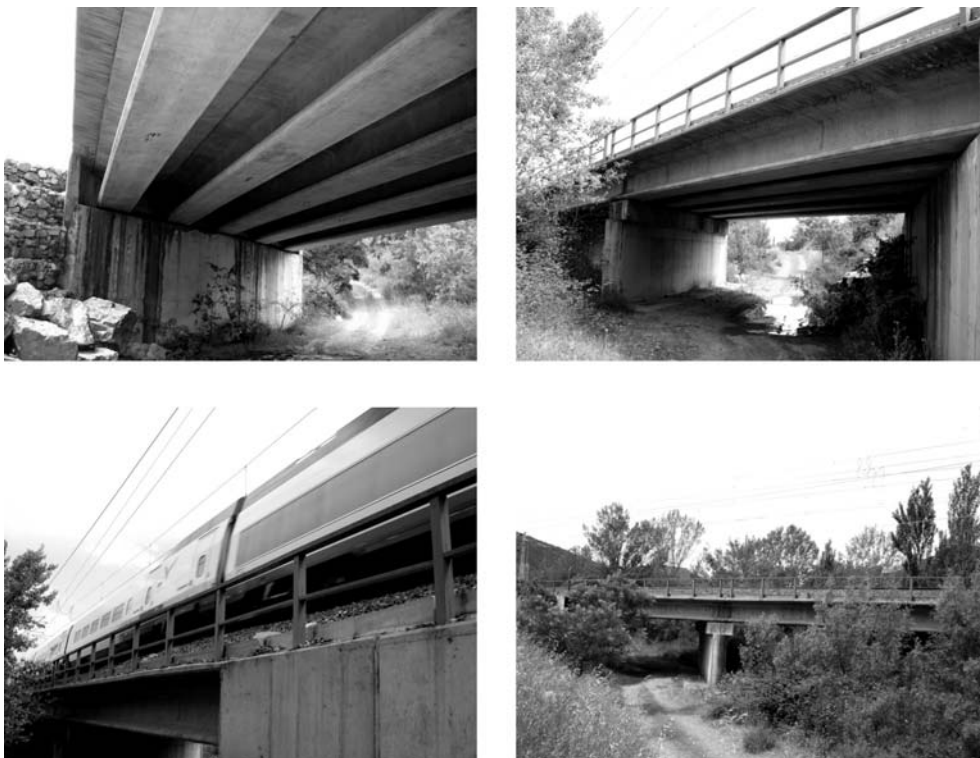
Figura 7.6 Imágenes del puente Arroyo Bracea II
