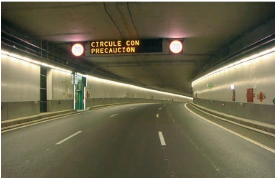
Figura 10.12. Túneles de Calle 30.
