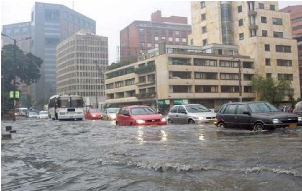
Figura 4-1. Inundación por mal funcionamiento de la red de captación
