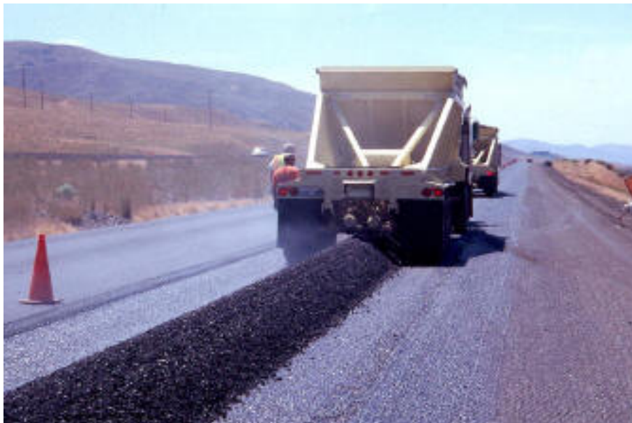
Fig: descarga de material en cordón por el vientre de la caja
