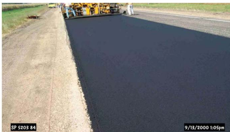
Figura 1A: temperatura uniforme durante la pavimentación usando un elevador de material en cordón (imagen digital)
