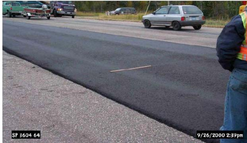
Figura 6A: punto parada/ arranque de la extendedora de 30 minutos (imagen digital)
