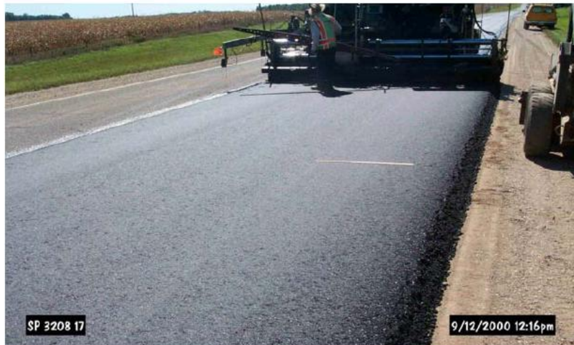
Figura 3A: Veta longitudinal (imagen digital)
