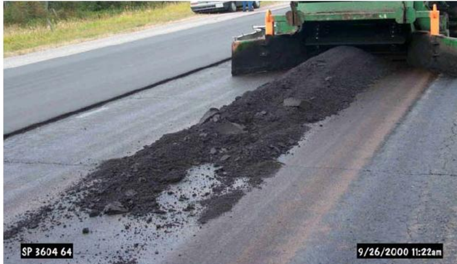
Figura 7A: Cordón de material frío antes de la extendedora (imagen digital)
