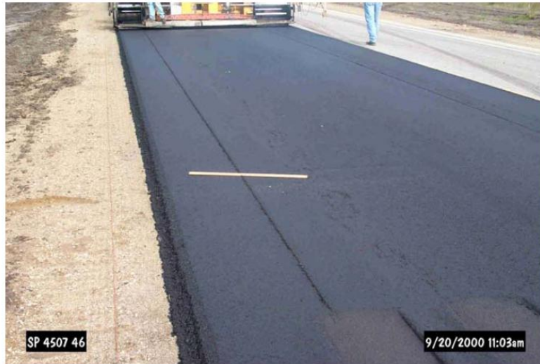
Figura 5A: punto típico de parada/ arranque de la extendedora (imagen digital)
