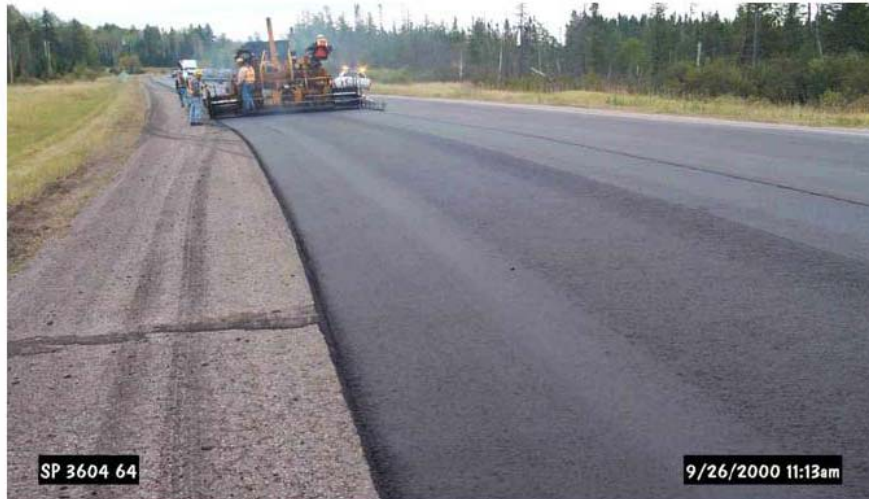
Figura 7A: Cordón de material frío después de la extendidora (imagen digital)
