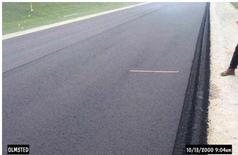
Figura 9A: Efectos del clamshelling sobre la capa (imagen digital)
