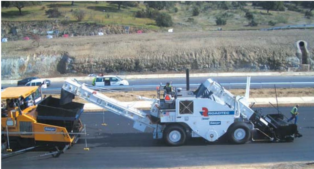
Fig: silo de transferencia
