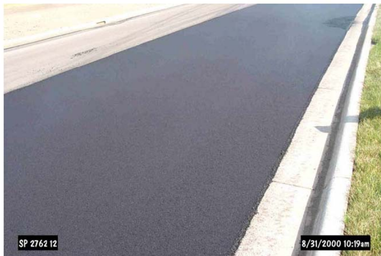
Figura 2A: temperatura uniforme durante la pavimentación de vertido directo desde camión (imagen digital)
