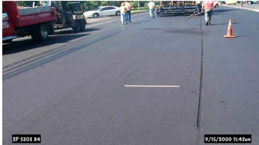
Figura 8A: Vaciado la extendedor durante la pavimentación (imagen digital)
