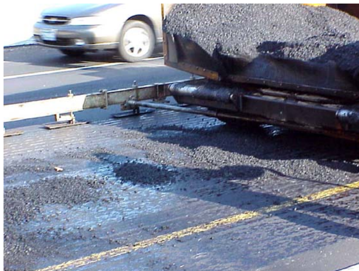
Fig: Derrame de la mezcla
