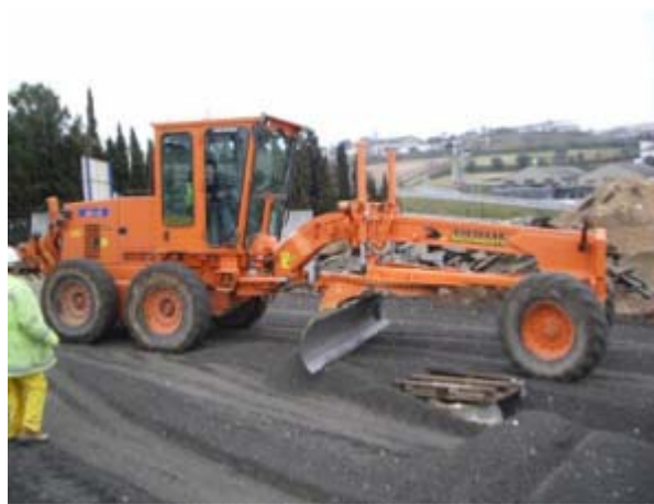
Figura 6. Extendido y compactado en obra de escorias de RSU
