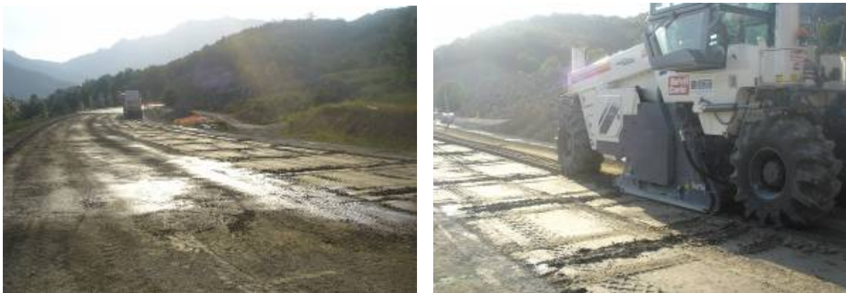
Figura 1. Estabilización de suelos
