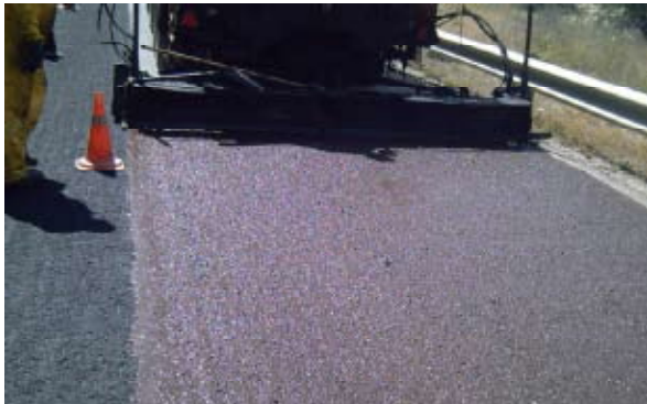
Extendido lechada con polvo de caucho.
