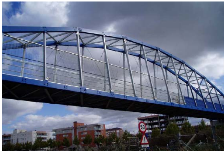
Figura 3.27: Puente en materiales compuestos de la ciudad de Lérida.
