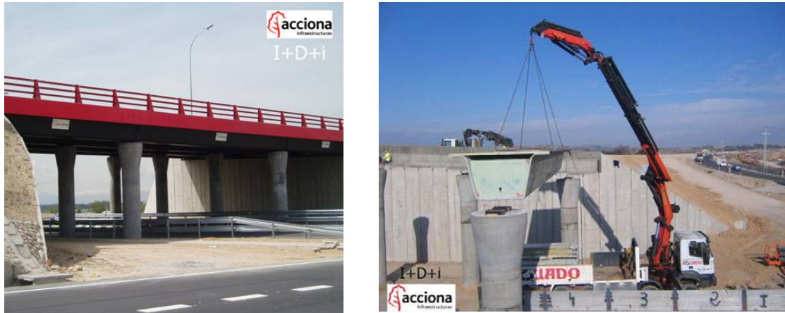
Figura 3.29: Aplicación de materiales compuestos en viaducto carretera M-111, Madrid.
