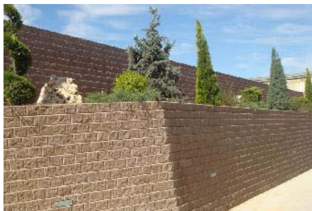
Figura 2.11: Muro de bloques prefabricados de hormigón.
