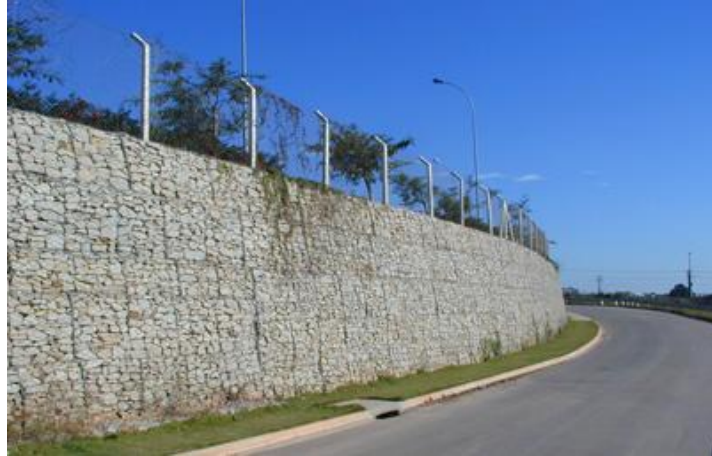
Figura 2.6: Muro de contención de gaviones.
