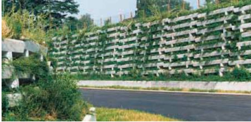
Figura 2.10: Muro de módulos prefabricados verdes.
