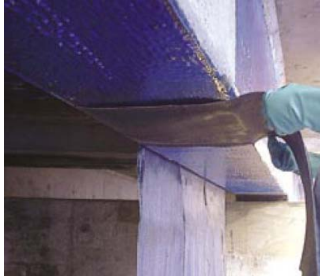
Figura 3.31: Aplicación de materiales compuestos en vigas de puentes.
