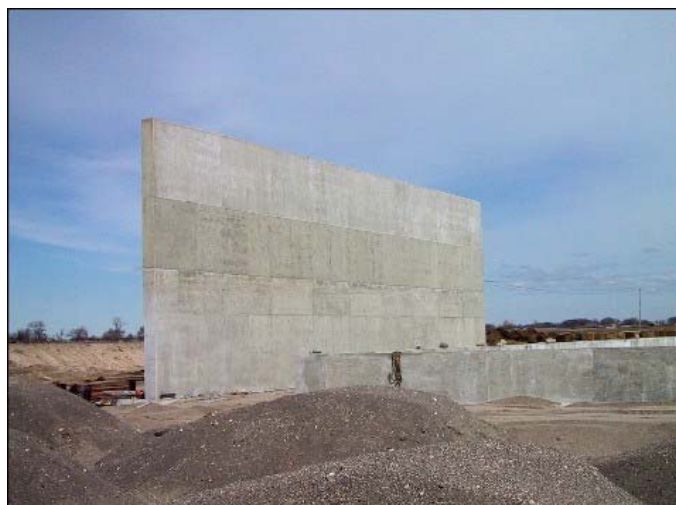
Figura 2.8: Muro de contención tipo ménsula.
