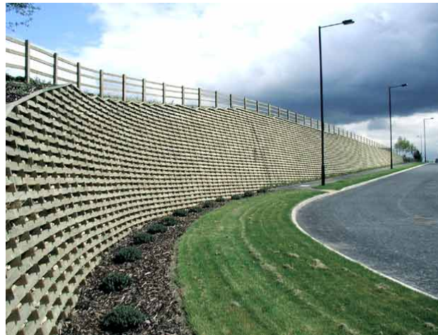
Figura 2.5: Muro de contención tipo cribas.
