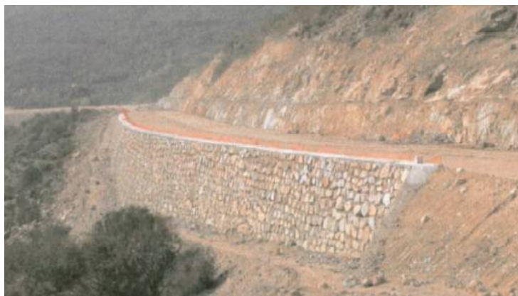
Figura 2.7: Muro de contención de escollera.
