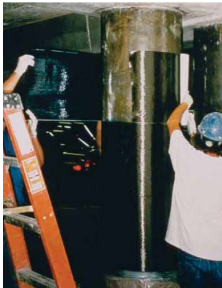
Figura 3.32: Aplicación de materiales compuestos en refuerzo de pilares.
