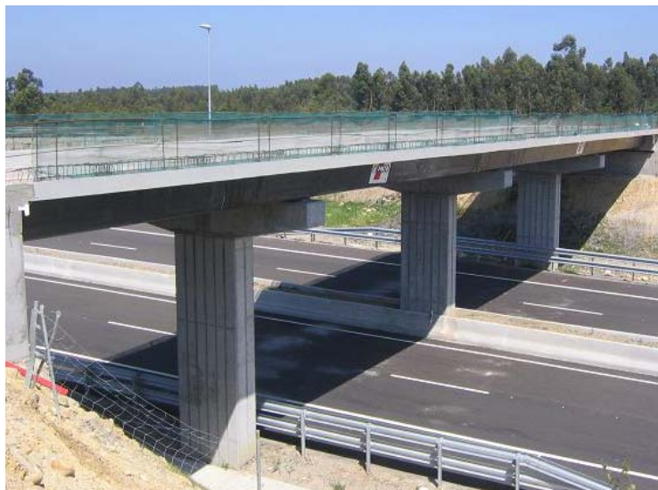
Figura 3.28: Aplicación de materiales compuestos en paso superior Autovía del Cantábrico.
