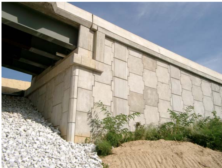
Figura 1.3: Aplicación de muro de tierra mecánicamente estabilizada.
