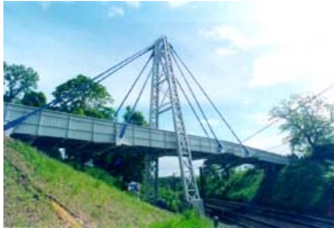
Figura 3.25: Aplicación de materiales compuestos en el puente de Holding, Dinamarca.
