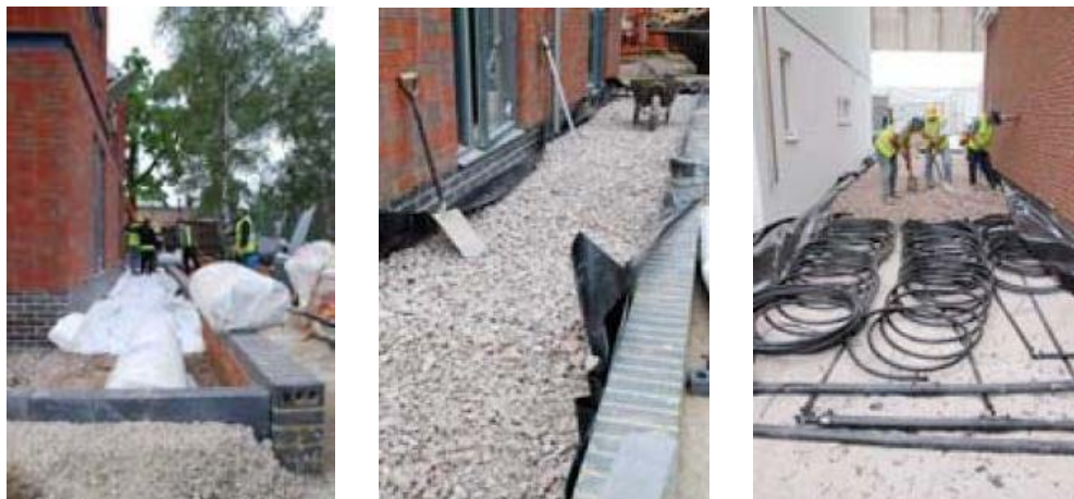
Figura 5. Instalación de un sistema de bombas de calor geotérmicas integrado en la subbase de un firme permeable. Hanson EcoHouse (Coupe y Nnadi, 2007).
