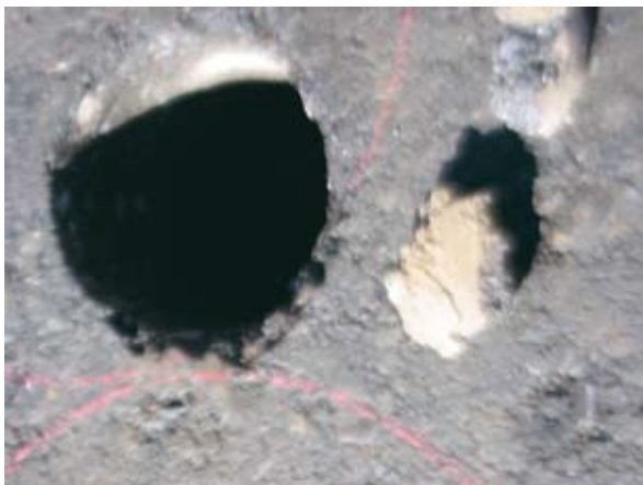
Figura 7. Perforación de testigo a las 22 horas.
