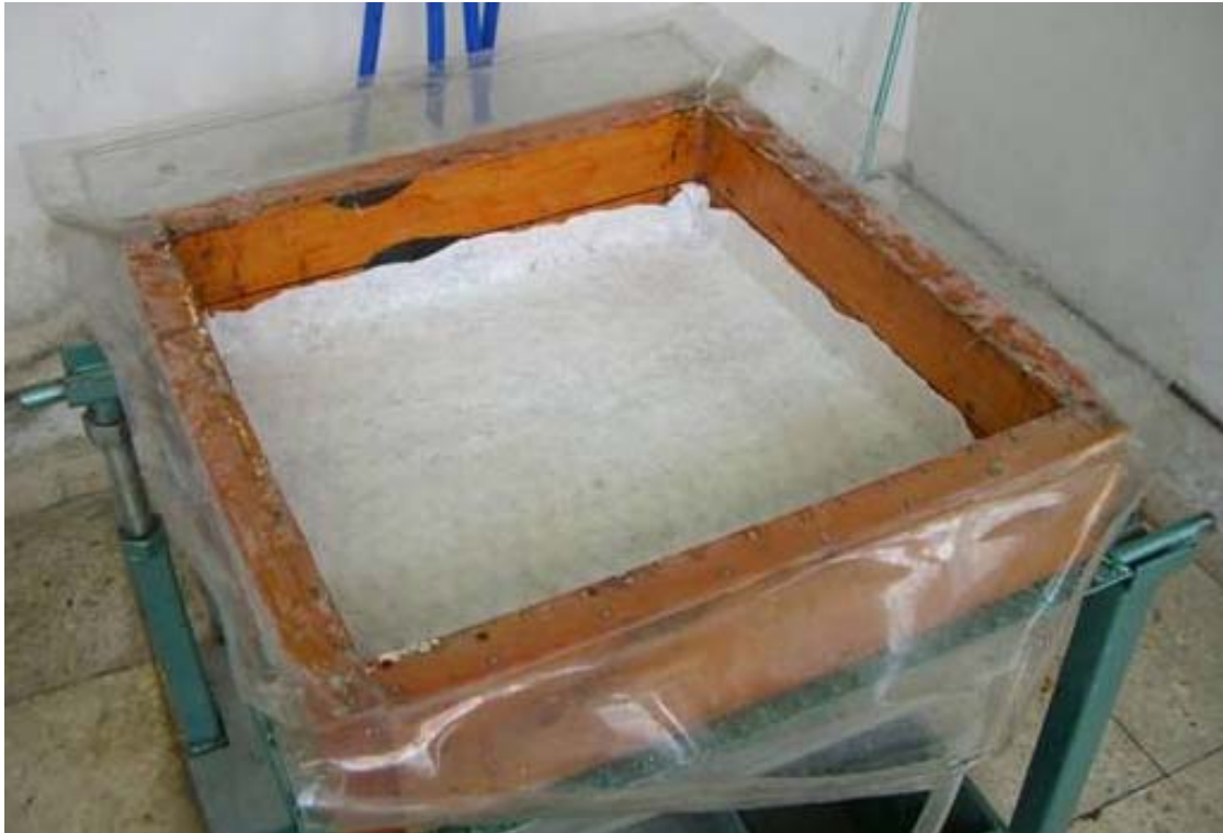
Figura III-3. Construcción de la muestra de pavimento permeable para ensayar en el ICF: colocación del geotextil de asiento.
