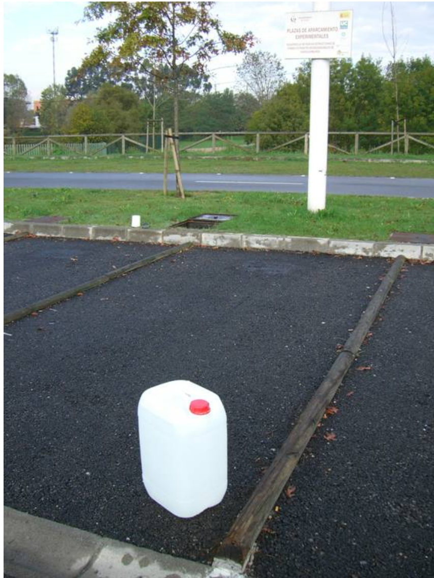
Figura III-47. Aportación de agua artificial o precipitación simulada sobre una plaza experimental de firme permeable del aparcamiento de la Guía, Gijón.
