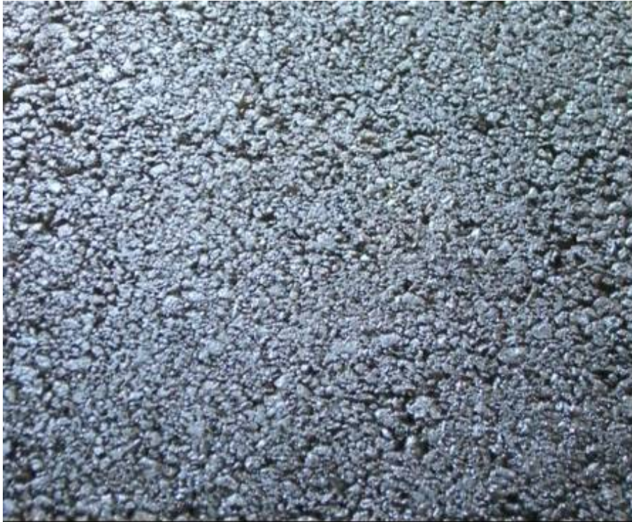
Figura II-4. Mezcla bituminosa porosa, Laboratorio de Caminos de Santander.
