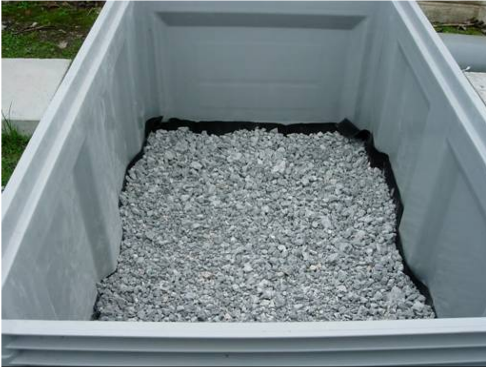
Zahorra drenante de los contenedores del Campus de Santander.
