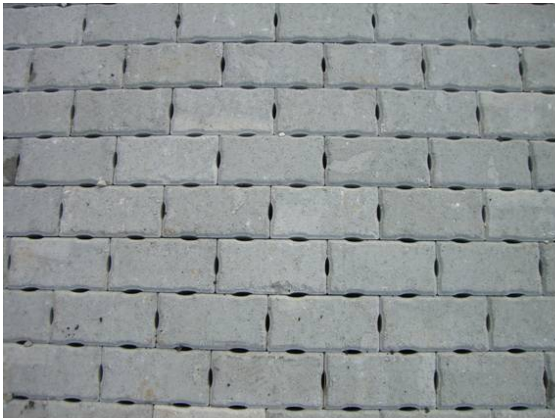
Figura II-3. Adoquines de Bloques Montserrat con ranuras libres, aparcamiento experimental del Parque de las Llamas, Santander.
