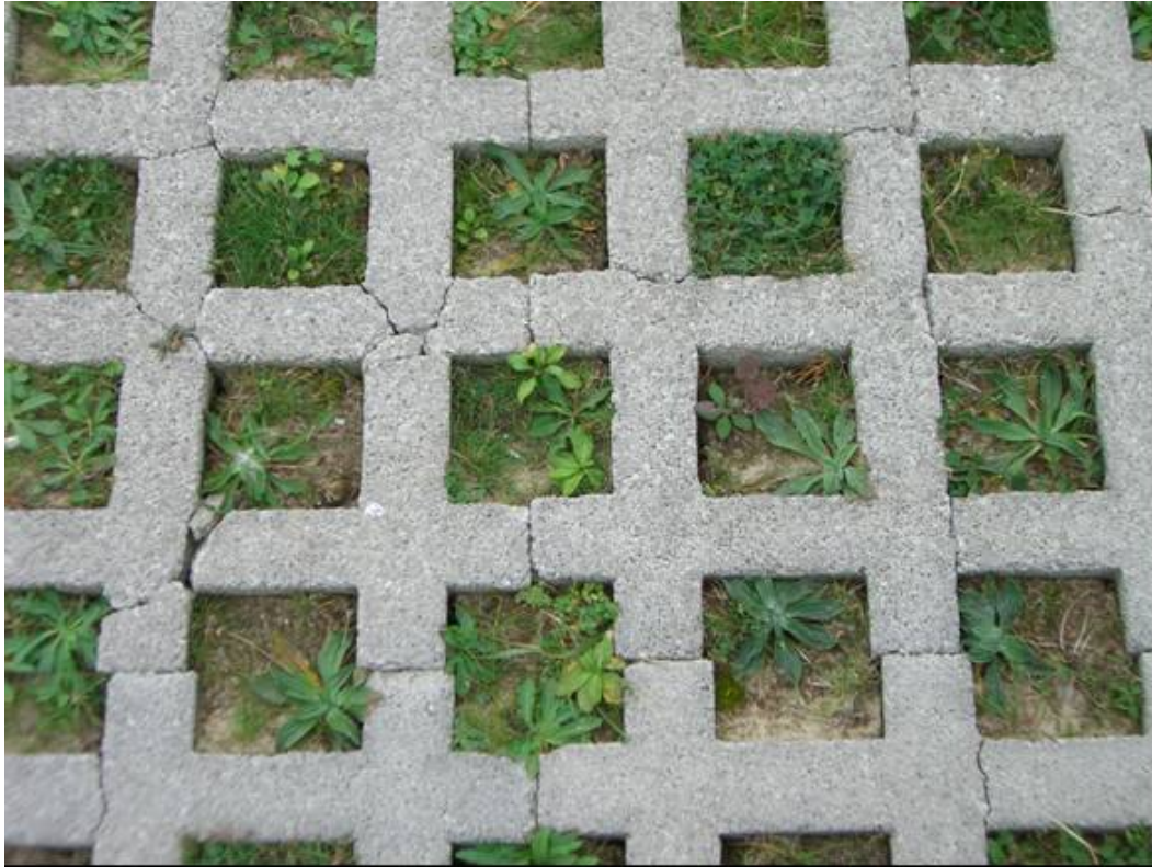
Figura II-1. Césped con refuerzos de hormigón, aparcamiento de la playa de Loredo, Cantabria.
