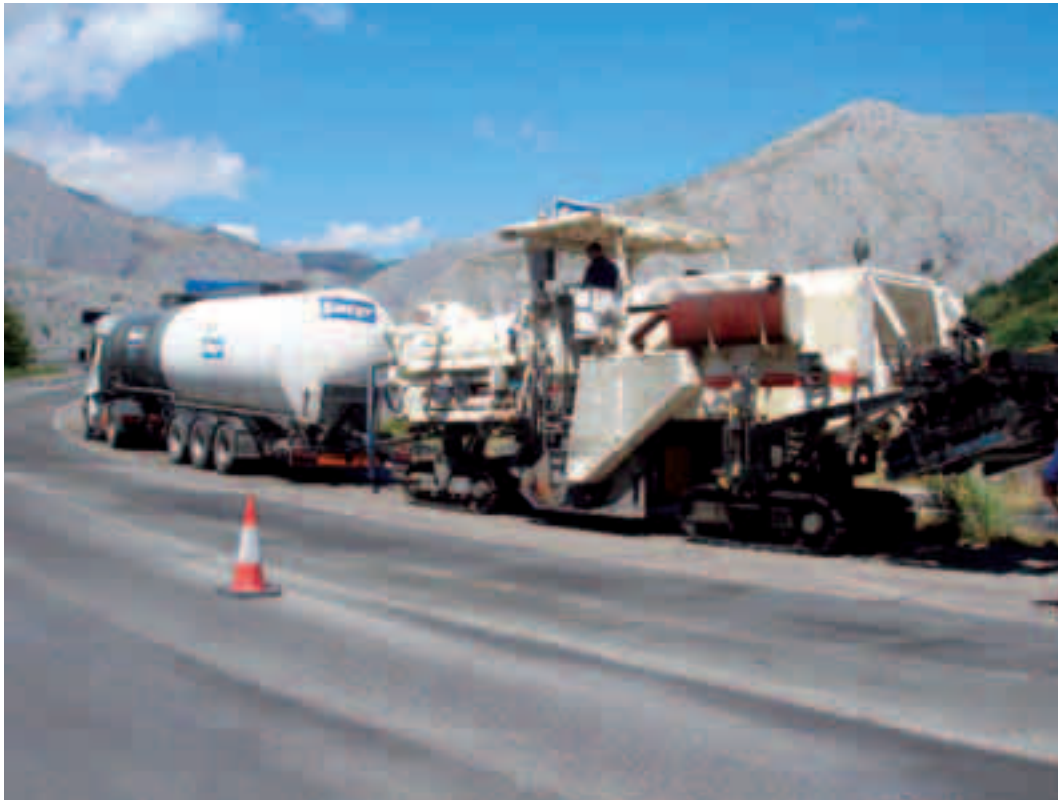
Figura 4.- Ejecución del reciclado en frío
