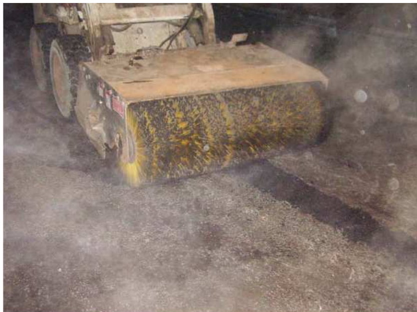
Fig.3.15 Limpieza del material bituminoso sobrante.
