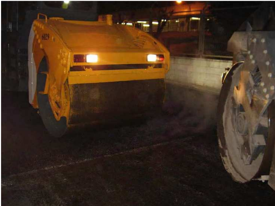
Fig.3.14 Compactación de la mezcla de los tramos con adición de polvo de neumático con vía seca.
