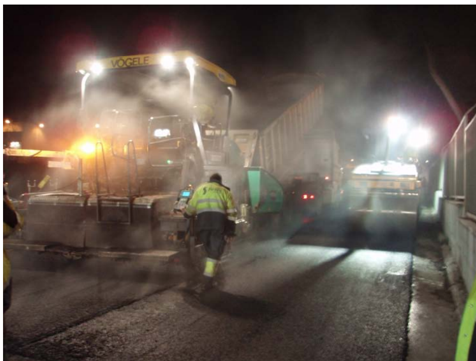
Fig.3.13 Extendido de la mezcla de los tramos III(A y B) y IV(A y B).
