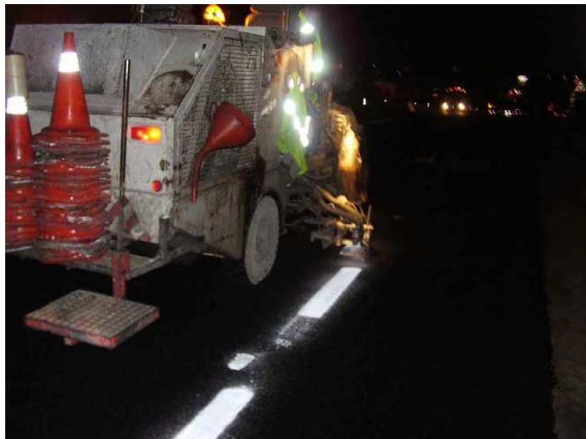
Fig.3.16 Señalización y puesta en servicio de la carretera.
