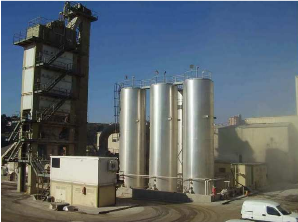
Fig.3.10 Vista general de la planta.
