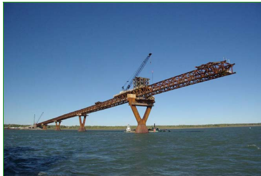
Estructura metálica del puente de Deh Cho después del lanzamiento norte y durante el izado del pilón
