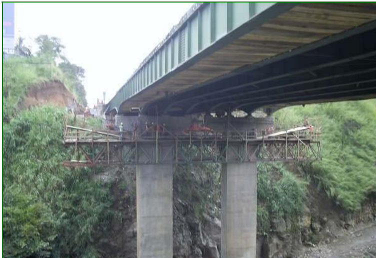
Puente sobre el río Tiribí, en Costa Rica
