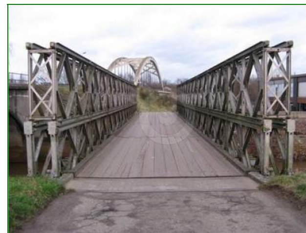
Puente Bailey en Costa Rica
