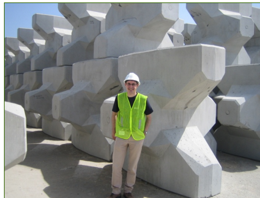
Delante de un acopio de bloques ACCROPODE™ de 3m3 en Ras Laffan (Qatar)
