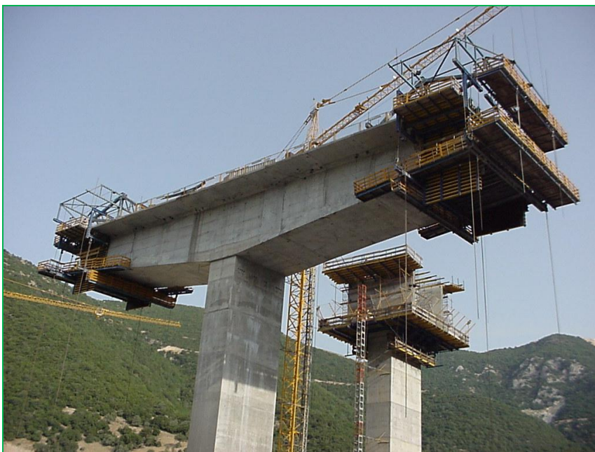
Carros 'FormTraveller' en viaducto en Grecia
