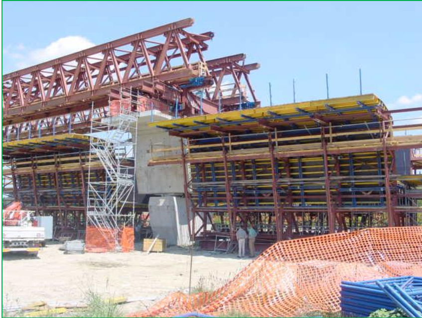
Carro 'Varos' en viaducto sobre el río Tanaro (Italia)
