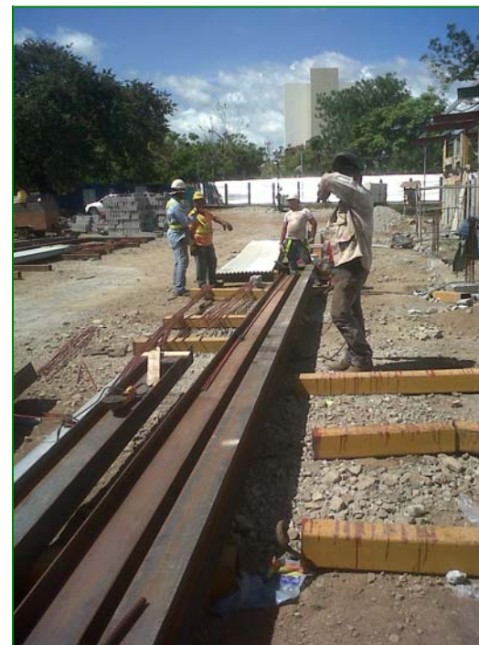
Preparación a pie de tajo de vigas metálicas estructurales
