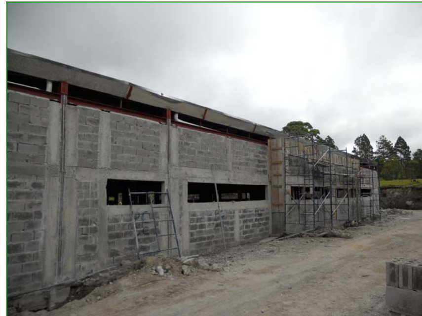
Detalle de cerramiento exterior con fábrica de bloque. La normativa de edificación exige la disposición de vigas y columnas de refuerzo cada tres metros.
