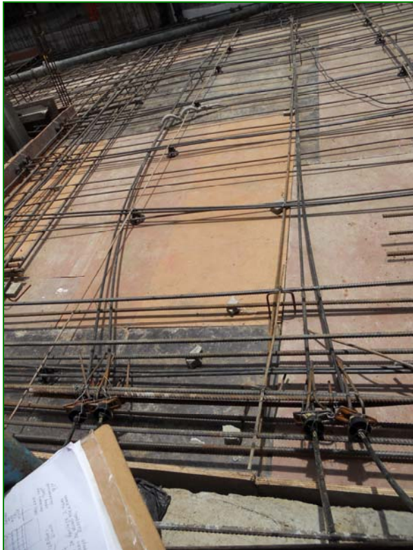
Inicio de armado de un forjado con la disposición de los cordones de postesado
