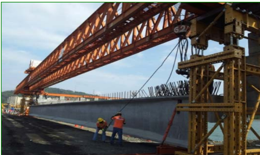
Lanzamiento de las vigas longitudinales. Cinta Costera III
