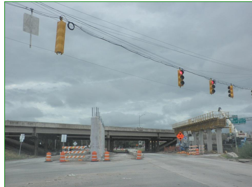
Construcción del puente de Yucca. Forth Worth, Texas 2015
