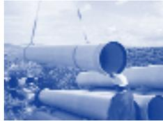
Fig. 2 - Descarga de tubos
