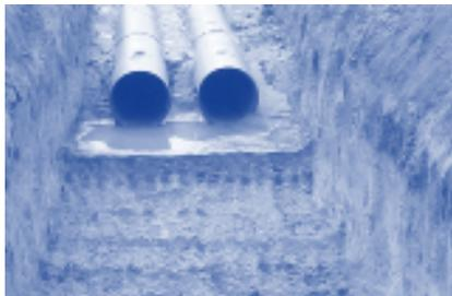
Fig. 9 - Rasanteo y anchura de la base de la zanja
