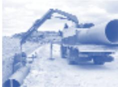
Fig. 1 - Descarga de tubos
