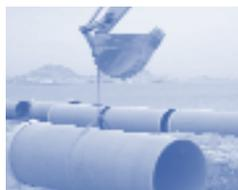
Fig. 15 - Utilización de eslingas en la unión con pala mecánica
