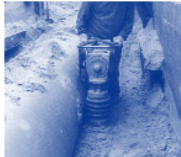
Fig. 20 - Compactación del relleno en los laterales
