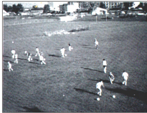
Figura 4: Depósito de retención con derivación, en Denver. Está siendo usado como campo deportivo en épocas de tiempo seco
