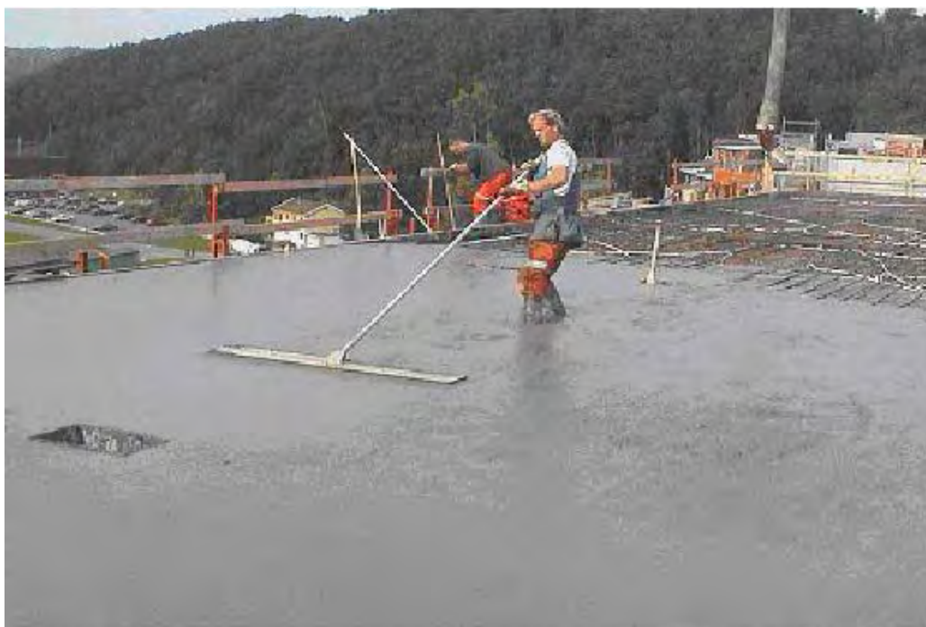
Figura 11.1 Nivelado del HAC con una regla flotante
