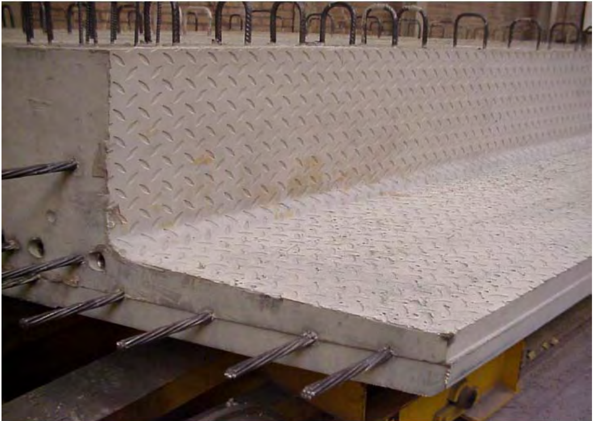
Figura 5.1: Acabado superficial de un elemento prefabricado con HAC con llenado completo del molde.
