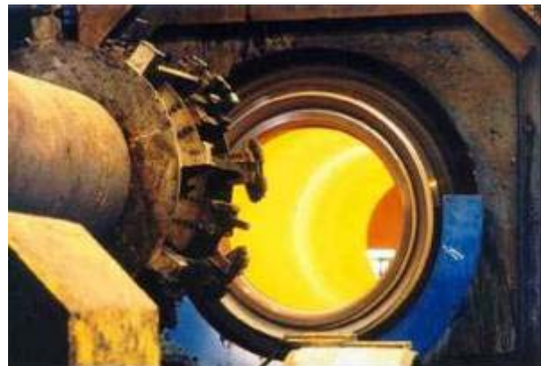
Fig.24 Extracción del tubo
