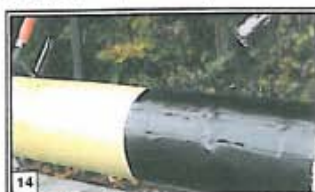
6 Dirigir la llama, en el centro y en la dirección del perímetro, hasta el parche de cierre. Seguidamente, realizar la retracción de la banda hacia uno de los extremos en dirección radial
