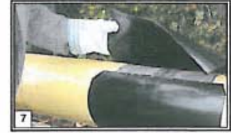
13 Alinear la banda termorretráctil retráctil. Retirar completamente la película protectora. La banda termorretráctil debe apoyarse sobre la superficie del tubo.
