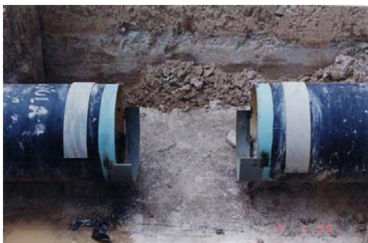
Fig. 65 Preparación de piezas a unir. Soldadura de un carrete.
