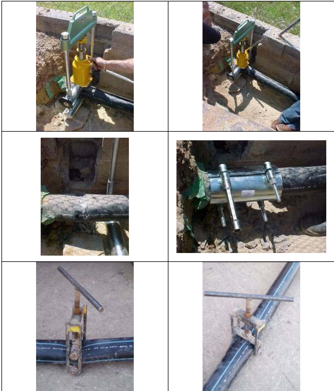
Fig. 97 Pinzamiento de un tubo
