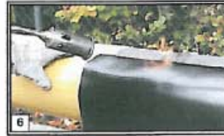
8 Presionar con la mano sobre la banda termorretráctil montada, calentar con una llama azul-amarilla y volver a presionar el manguito con las manos.
