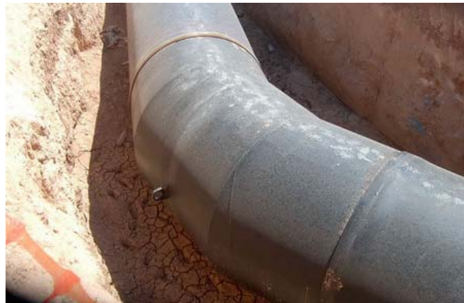
Fig. 78 Pieza especial: Codo soldado.
