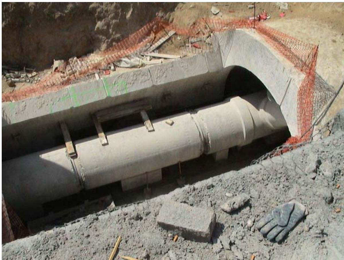
Fig. 50 Demolición de juntas exteriores
