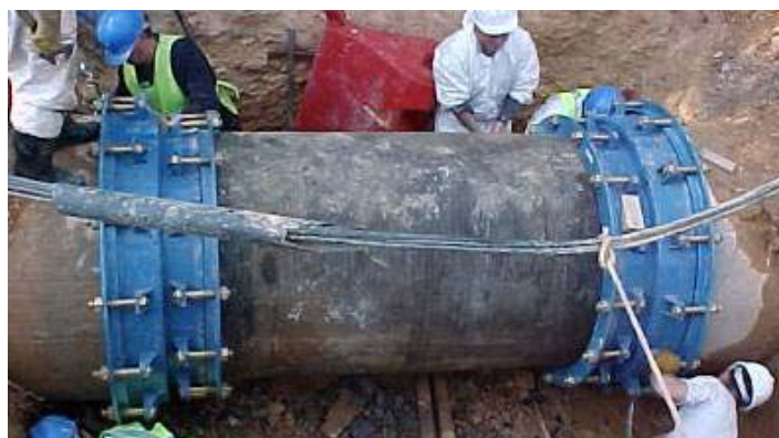
Fig. 13 Operarios apretando tornillería de acoplamiento de gran tolerancia
