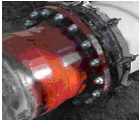
Fig. 88 Unión mediante bridas.
