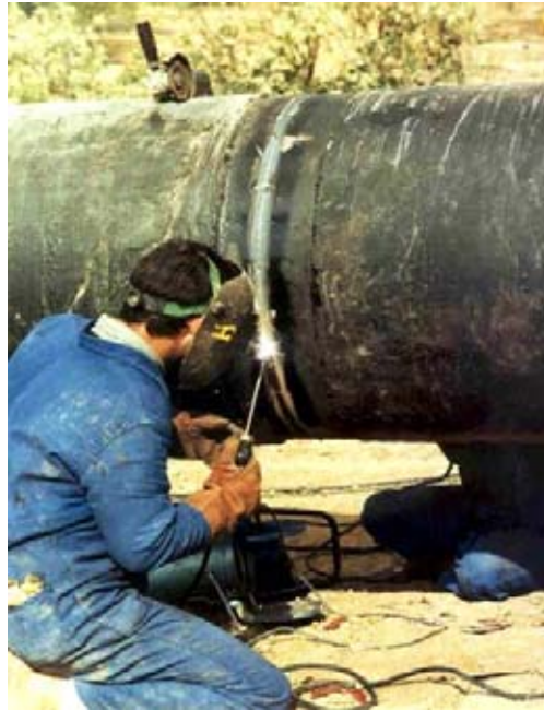
Fig. 63 Soldadura exterior
