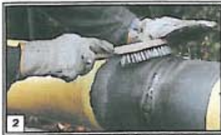
2 Limpiar la superficie del tubo con un cepillo de acero manual, eliminando el óxido, la suciedad y otros restos. Los restos aceitosos o grasientos deberán eliminarse con un disolvente apropiado.
