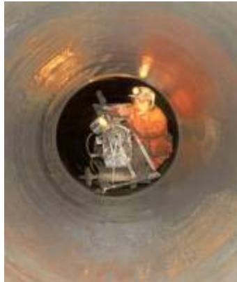
Fig. 117 proyección de mortero
