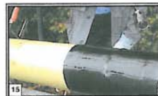
11 Empezando otra vez por abajo, retraer la banda en sentido radial hacia el otro extremo.
