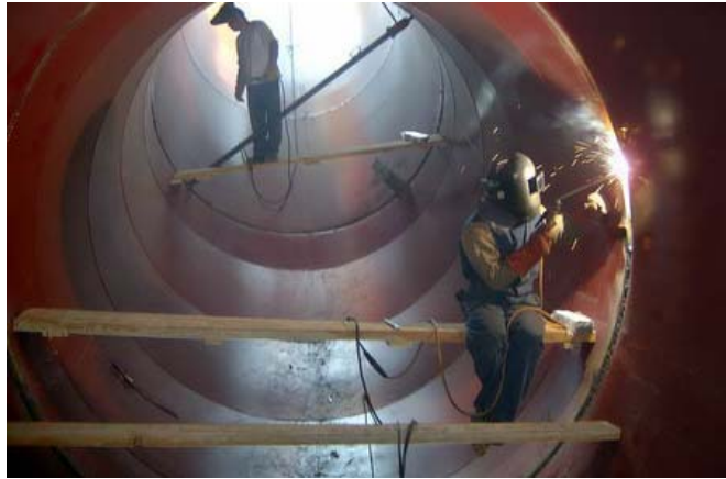
Fig. 81 Soldadura interior.
