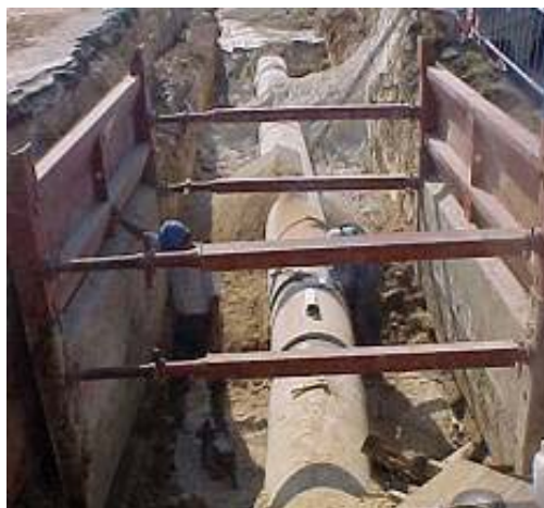
Fig. 9 Entibación en zanja para reparación
