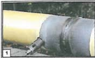
1 Calentar la superficie del tubo hasta que tenga el calor de la mano. De este modo la superficie está lo suficientemente seca para proseguir con el tratamiento.
