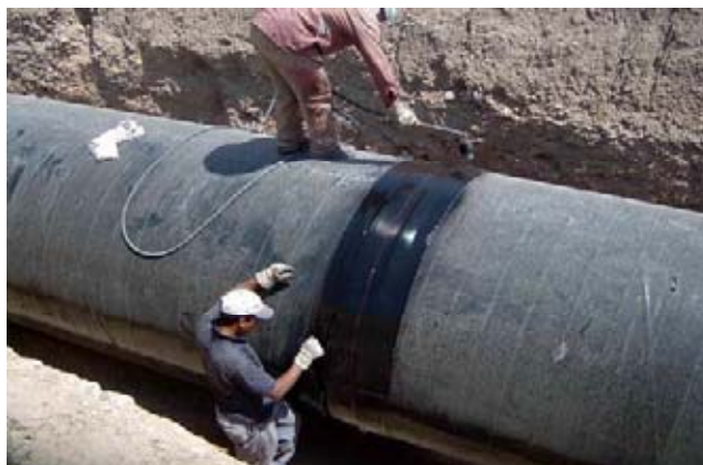
Fig. 87 Calentamiento final en la colocación del manguito termorretráctil.
