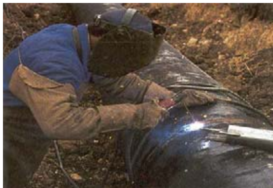
Fig. 79 Soldadura exterior.
