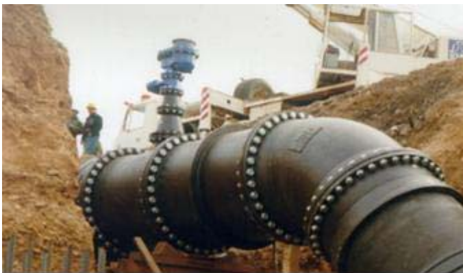
Fig. 29 Junta de bridas.
