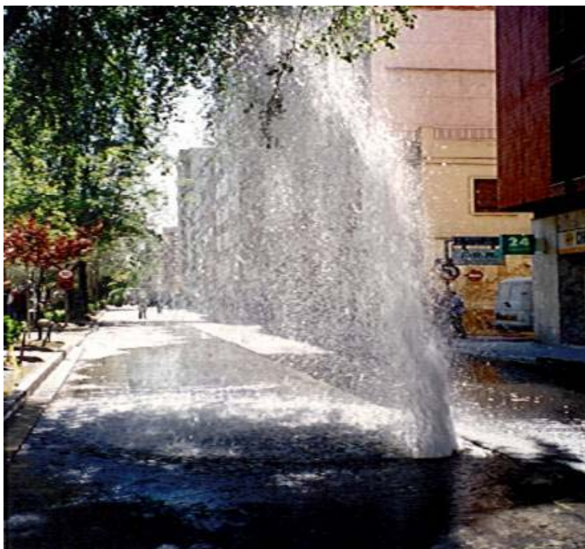
Fig. 4 Avería en una tubería
