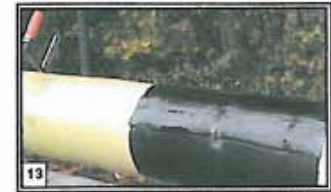
15 Empezando por la parte inferior del tubo, calentar la banda termorretráctil con una llama azul-amarilla a lo largo del cordón de soldadura hasta que la banda se retraiga.
