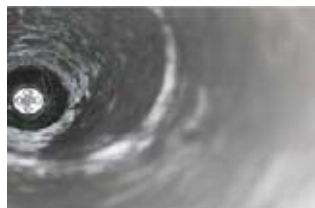
Fig. 118 proyección de resinas
