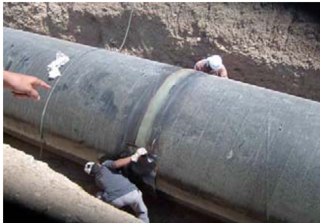
Fig. 85 Recubrimiento de la unión entre tuberías mediante manguito termorretráctil.
