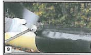
9 Calentar el lado que lleva el pegamento del parche de cierre con la llama de gas. Colocar el lado calentado sobre la zona de solapado de la banda termorretráctil.
