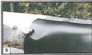
3 En la posición de las 10 horas o las 2 horas, colocar la banda termorretráctil en dirección axial de tal forma que el revestimiento industrial quede solapado homogéneamente a ambos lados.
