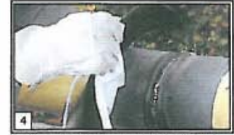
12 Retirar la película de protección de la banda en toda la anchura y en una longitud de aprox. 150 mm.
