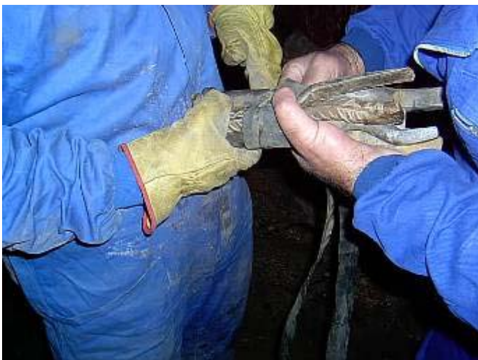
Fig. 35 Diversas fotografías del procedimiento de retacado con plomo en frío
