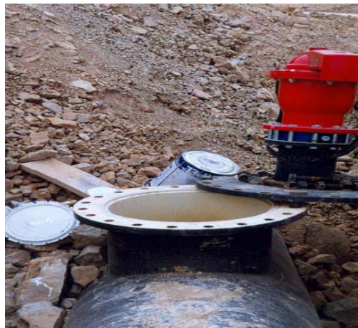
Fig. 71 Unión mediante bridas.
