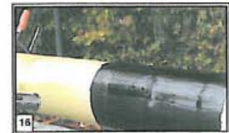
16 El proceso de retracción ha finalizado cuando el caucho empieza a salir por los lados.
