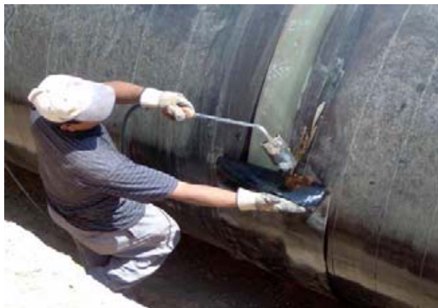
Fig. 86 Calentamiento inicial en la colocación del manguito termorretráctil.
