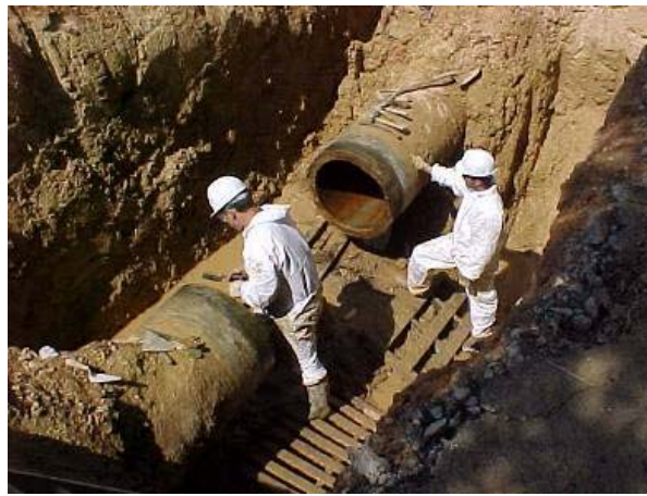
Fig. 16 Operarios reparando avería en tubería de fibrocemento
