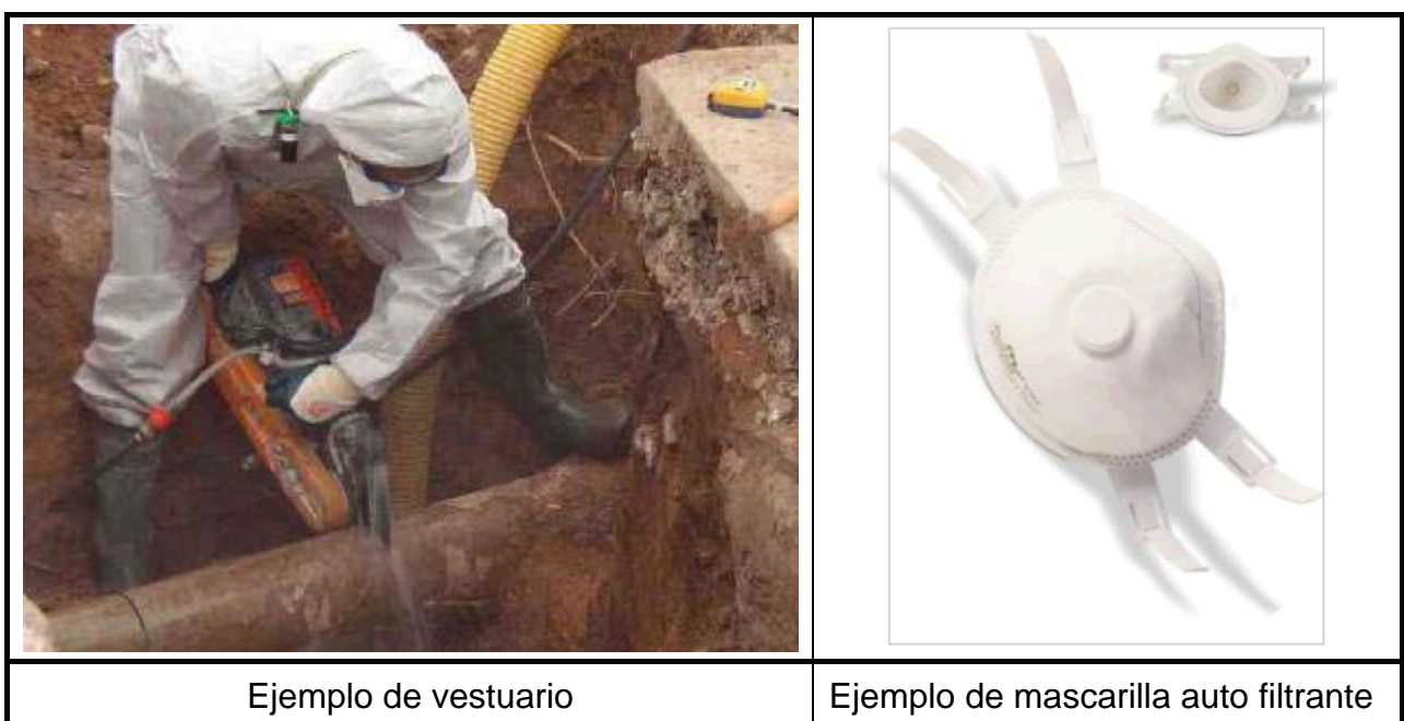
Fig. 17 Equipos de seguridad para el corte de tubería de fibrocemento
