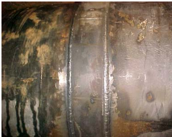
Fig. 80 Uniones soldadas mediante virolas.
