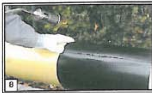
4 Calentar regularmente la zona de solapado y presionar la banda con los guantes.
