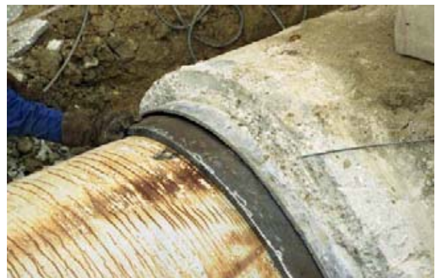
Fig. 56 Soldadura a las boquillas
