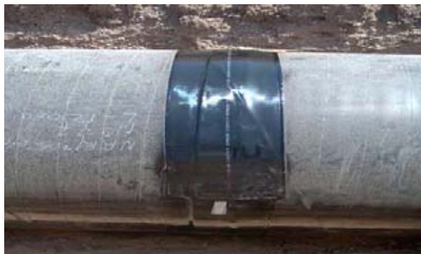
Fig. 84 Revestimiento de la unión de tuberías mediante encintado en frío.
