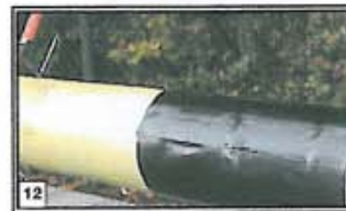
10 Antes de la retracción de la banda termorretráctil, dejar enfriar el parche de cierre hasta que tenga la temperatura de la mano.
