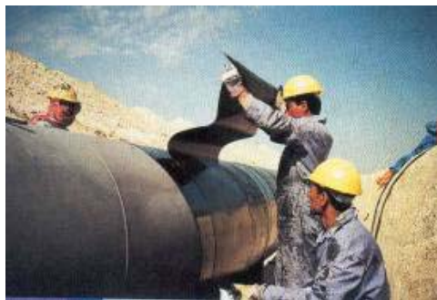
Fig. 59 Aplicación de cinta autoadhesiva.
