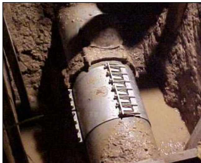
Fig. 11 Reparación de tubería con una abrazadera de reparación
